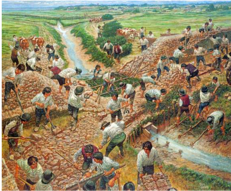
La construction des digues (Picard)
