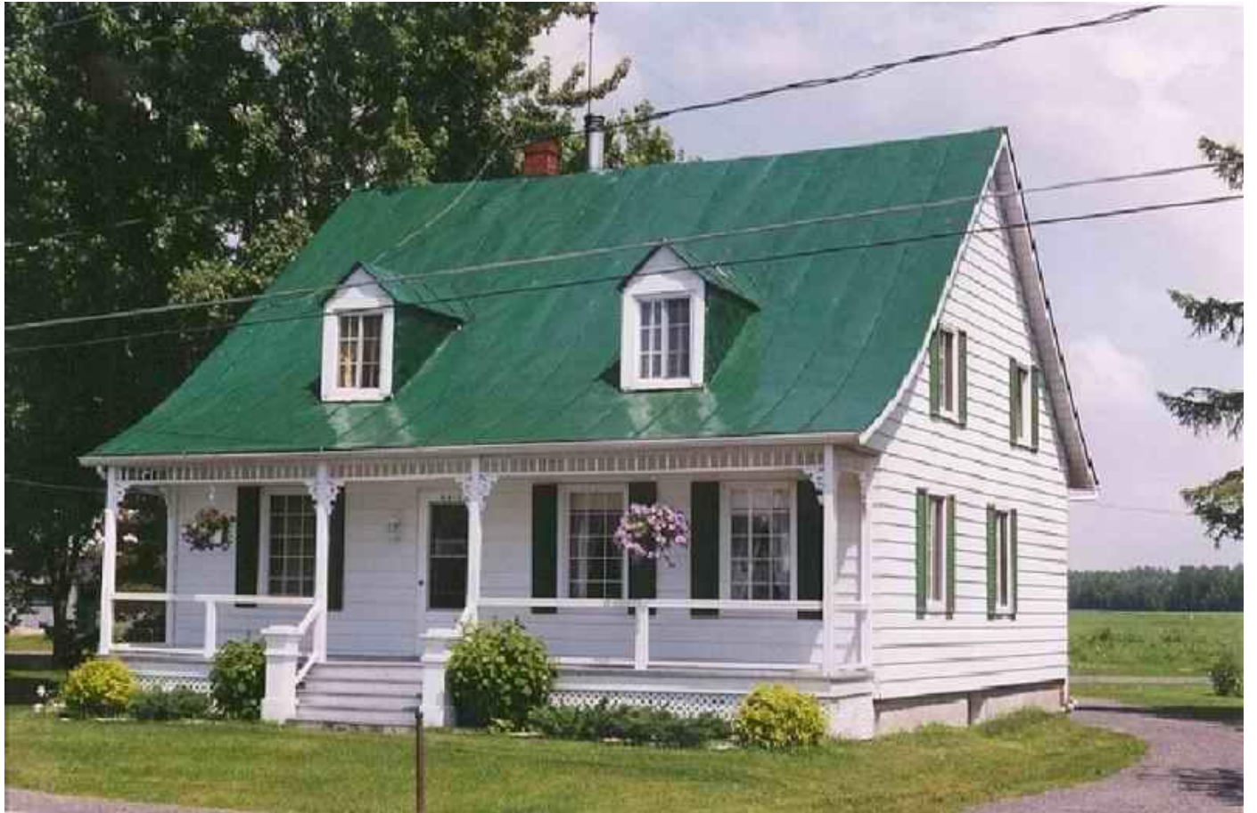
Maison ancestrale des Olivier dit Lavictoire sur la Grande-Côte à Berthierville.
