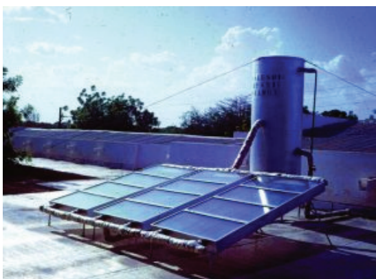
Chauffe-eau solaire produit par l'ONERSOL (vers 1971).
