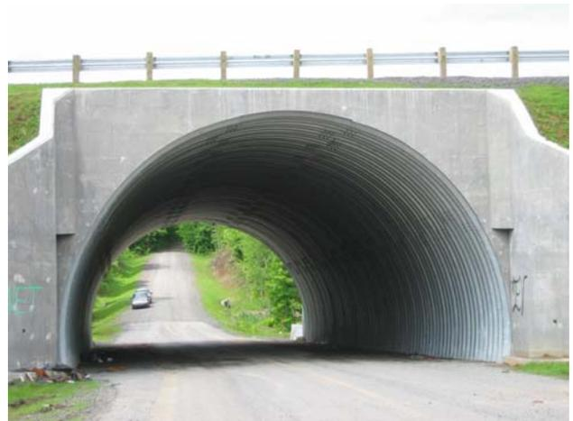
4. Tuyau voûté en tôle ondulée galvanisée sur semelle en béton
