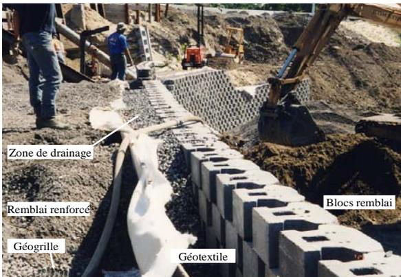
3. Mur remblai renforcé par des géogrilles avec paroi en blocs de béton imbriqués
