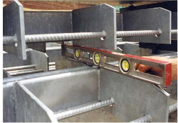
8. Vérification d'un joint de tablier (torsion)
