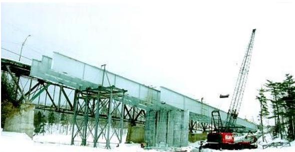
5. Ouvrage temporaire servant de support pour la mise en place des poutres
