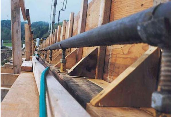
25. Rail de roulement pour équipement de finition pour le béton de la dalle
