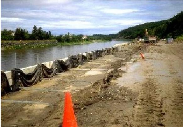
1. Mur à ancrages multiples avec paroi en béton armé
