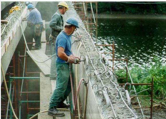
3. Démolition partielle avec marteaux pneumatiques 7 kg
