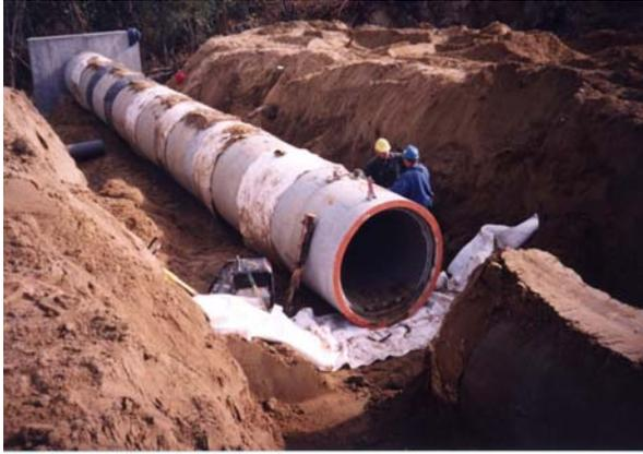
1. Installation d'un tuyau en béton armé (TBA)
