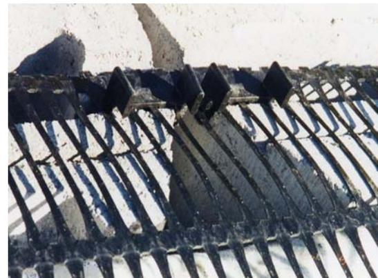
4. Connexion mécanique des géogrilles aux blocs remblai
