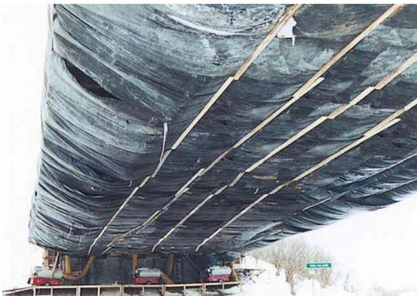
41. Protection type 3 – poutres dans l'abri et unités de chauffage hors abri
