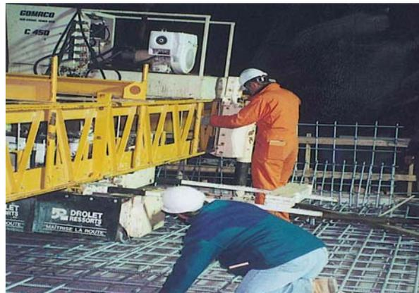
30. Ajustement du finisseur à béton automateur
