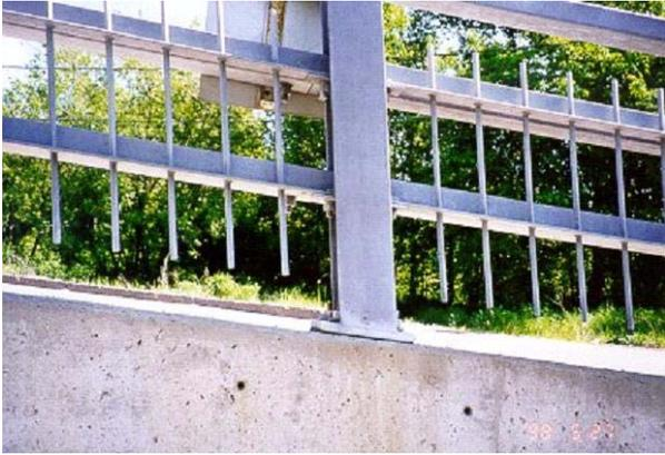
13. Dispositif de retenue avec poteaux posés selon la verticale (profil supérieur à 2 %)
