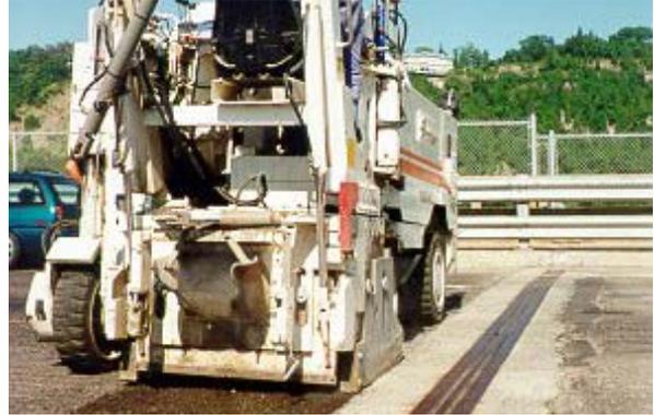
2. Planeur de faible largeur opérant près d'un joint de tablier
