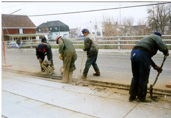
11. Sciage d'un joint froid (travaux en phases)
