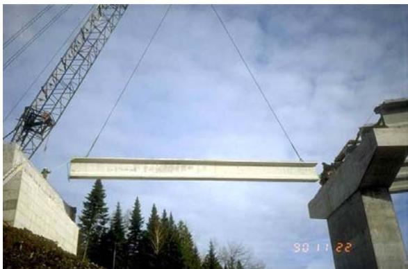
11. Mise en place d'une poutre préfabriquée
