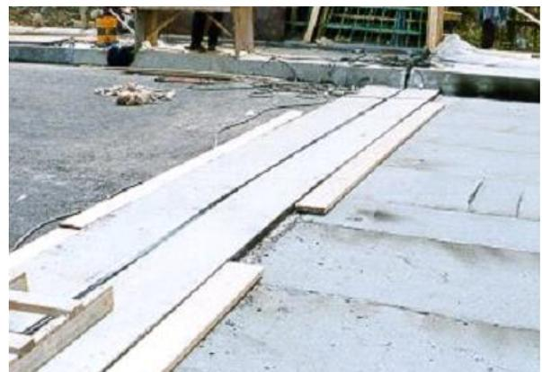
12. Protection des épaulements d'un joint de tablier après décoffrage
