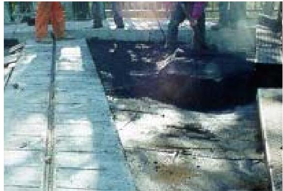
4. Biseau entre joint de tablier en biais et finisseur (correction sur dalle existante)
