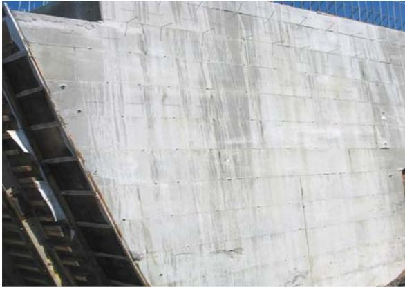
37. Béton décoffré avant correction des surfaces
