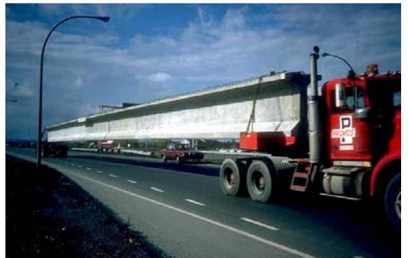
10. Transport d'une poutre préfabriquée
