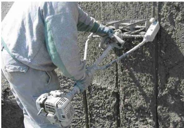
9. Arasement de la surface de béton
