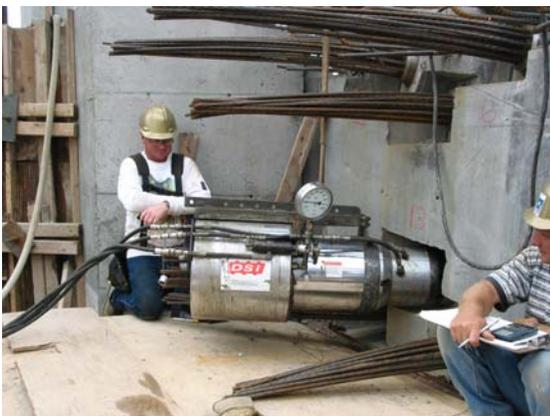
5. Mise en tension des armatures de précontrainte
