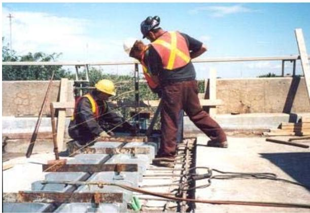
9. Mise en place d'un joint de tablier
