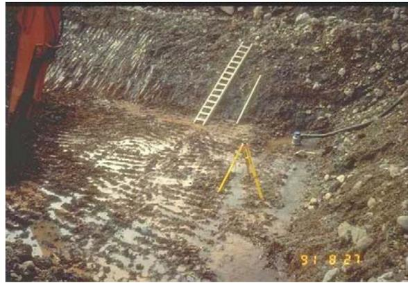
4. Fond d'excavation détrempé à assécher
