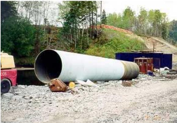
3. Pieu caisson (tube métallisé)
