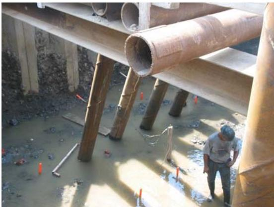
5. Fond d'excavation détrempé : nécessité d'un coussin de propreté
