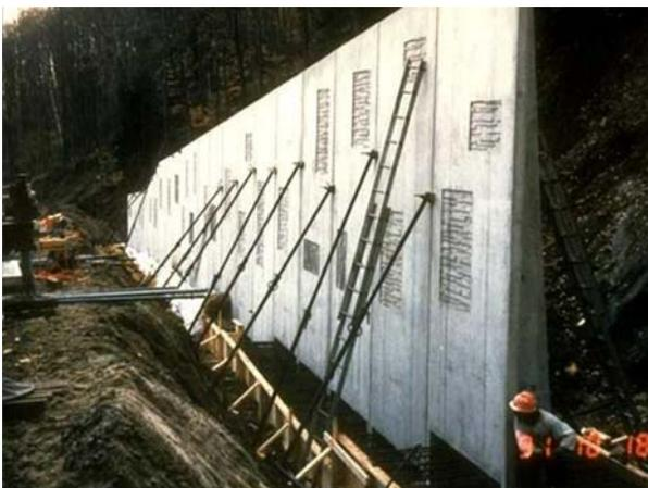
5. Mur en porte-à-faux en béton armé préfabriqué
