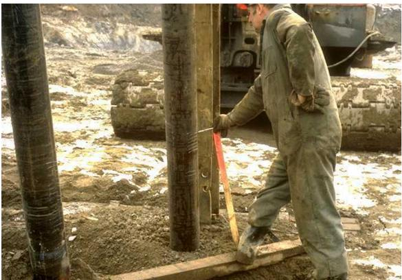
15. Mesure de l'enfoncement d'un pieu battu
