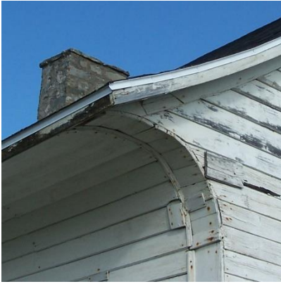
Toit à versant retroussé (arqué) et à larmier cintré à l'angle nord-ouest du Manoir Rioux-Belzile
