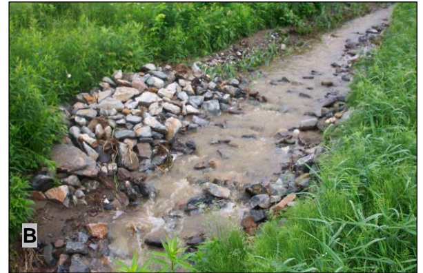
Figure 5 : État des bermes du site n° 10 à l'occasion de fortes précipitations (17 juin 2005) : A) berme n° 4 éventrée; B) berme n° 1 peu éventrée avec une importante sédimentation en amont
