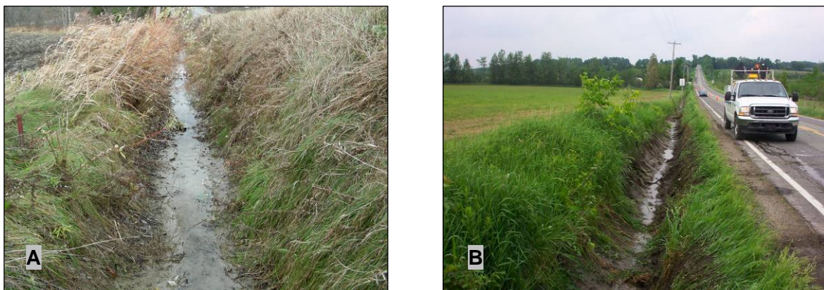
Figure 24 : Différence entre les profils transversaux du fossé du site no 3 : A) talus du côté de la route plus élevé que celui opposé au mètre 37,5 (11 novembre 2005); B) talus d'égale hauteur dans la moitié amont du fossé, au mètre 175 (13 juin 2005)
