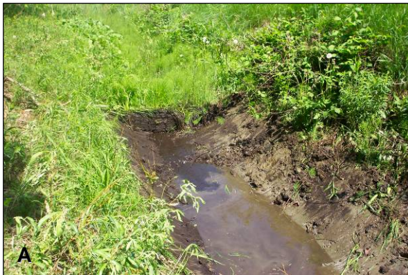
Figure 67 : Comparaison des méthodes de nettoyage au site n° 13 : A) fossé nettoyé à l'aide de la méthode du tiers inférieur au mètre 170 (9 juin 2005); B) même fossé nettoyé à l'aide de la méthode se rapprochant de la méthode traditionnelle et où les talus sont complètement dénudés (15 août 2005)
