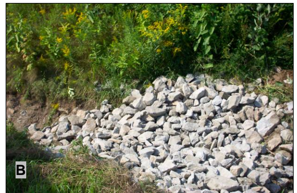
Figure 6 : Reconstruction des bermes filtrantes au site n° 10 (15 août 2005) : A) berme n° 3 en reconstruction; B) berme n° 3 recouverte de nouvelles pierres pour augmenter sa résistance
