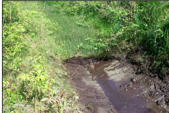
Figure 66 : État du site n° 13 au moment du nettoyage au mètre 128 (9 juin 2005)
