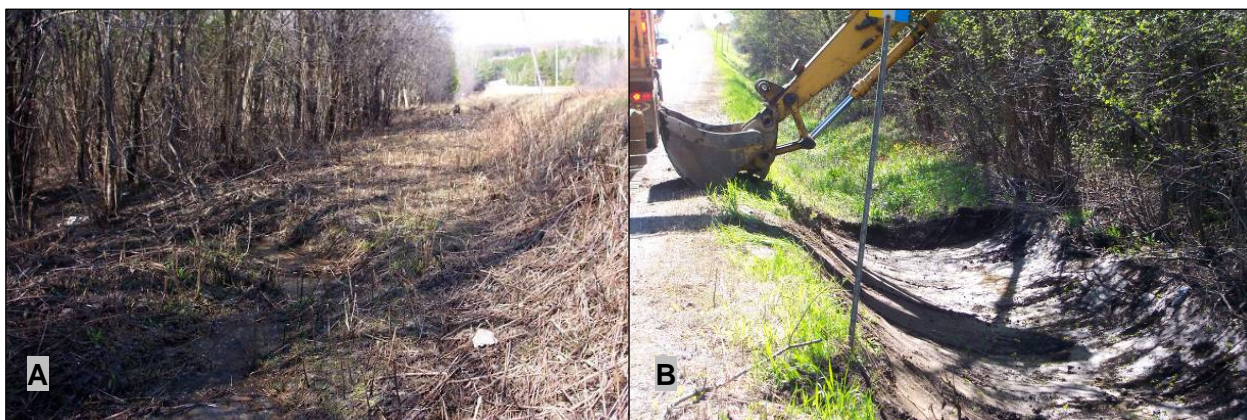
Figure 16 : Portion en amont du ponceau dans le fossé du site n° 1 : A) état du fossé avant le nettoyage (26 avril 2005); B) nettoyage de la zone d'accumulation où le talus opposé à la route est de faible hauteur (25 mai 2005)
