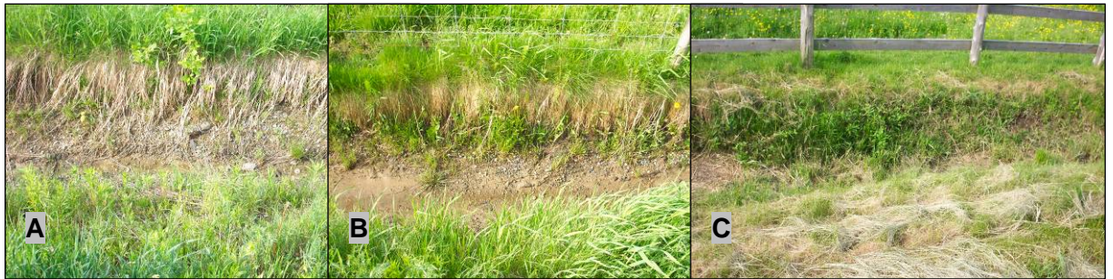
Figure 45 : Différence de densité de végétation dans le fond du site n° 8 avant le nettoyage (6 juin 2005) : A) faible densité de la végétation au mètre 87,5; B) végétation absente et érosion par sapement basal au mètre 12,5; C) végétation présente au mètre 162,5
