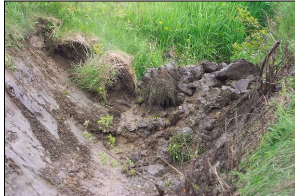
Figure 54 : Grande quantité de blocs découverts au moment du nettoyage du site n° 10 (30 mai 2005)
