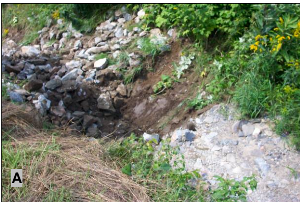
Figure 6 : Reconstruction des bermes filtrantes au site n° 10 (15 août 2005) : A) berme n° 3 en reconstruction; B) berme n° 3 recouverte de nouvelles pierres pour augmenter sa résistance
