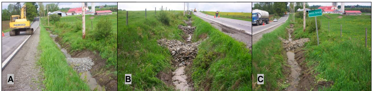
Figure 3 : Bermes filtrantes en aval du site n° 10 (31 mai 2005) : A) bermes avec des pierres de taille de 30 à 70 mm; B) bermes recouvertes de pierres de taille de 100 à 200 mm, vues de l'aval; C) bermes vues de l'amont
