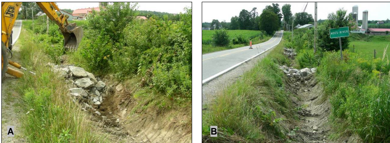
Figure 10 : Reconstruction des bermes en aval du site n° 10 (31 juillet 2006) : A) berme n° 4; B) bassins de sédimentation vus de l'amont
