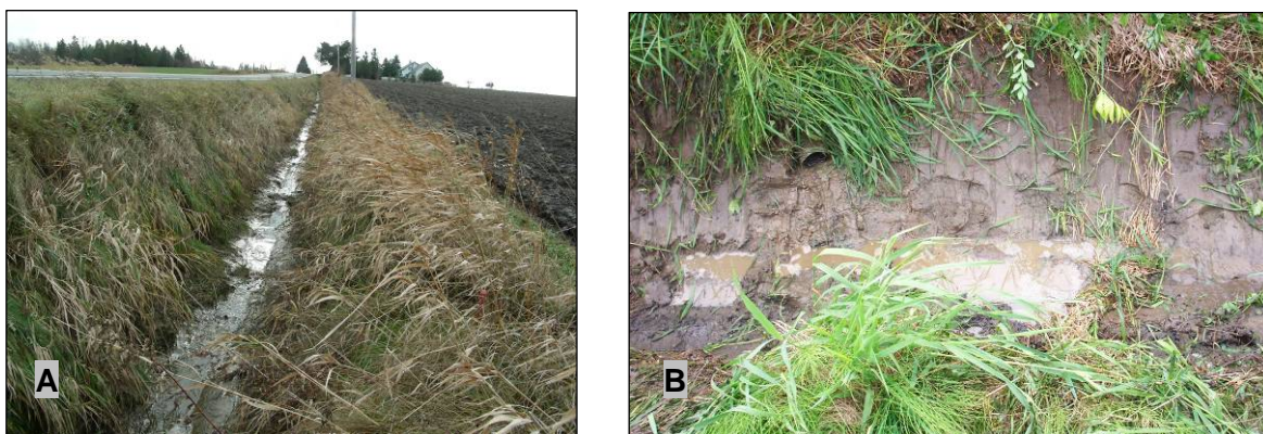
Figure 25 : Fossé du site no 3 : A) parcelle agricole labourée (11 novembre 2005); B) deux drains agricoles au mètre 170 (13 juin 2005)
