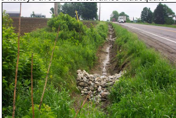
Figure 62 : Partie du bassin de drainage du site n° 12. Une bande de végétation sépare un champ du fossé. (13 juin 2005)
