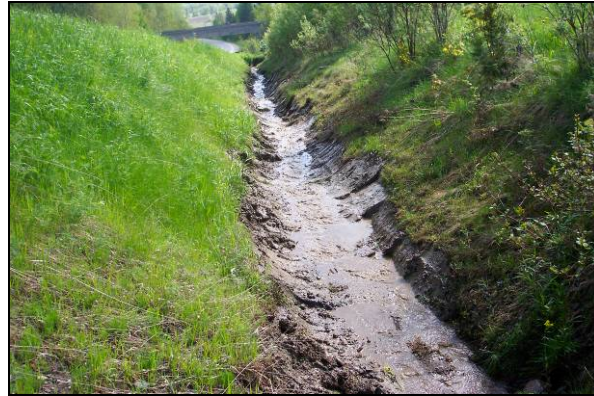
Figure 33 : Écoulement de l'eau dans le fossé lors du nettoyage du site no 5 (1er juin 2005)
