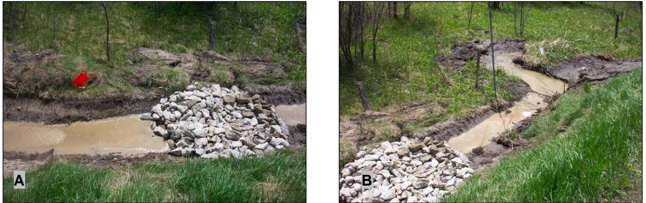
Figure 18 : Berme filtrante au site n° 1 (25 mai 2005) : A) berme installée près de la limite du site marquée par un piquet orange; B) portion en aval de la berme améliorée pour favoriser la sédimentation par la création d'un bassin naturel avec la végétation
