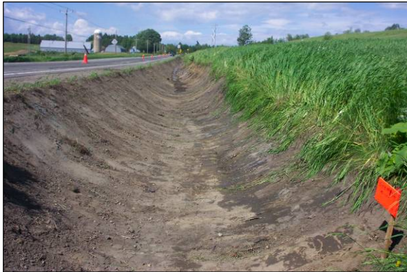
Figure 59 : Fossé du site n° 11 après le nettoyage à l'aide de la méthode traditionnelle (7 juin 2005) : A) profil transversal vu de l'aval du fossé; B) affleurements rocheux sur le talus du côté opposé à la route au mètre 37
