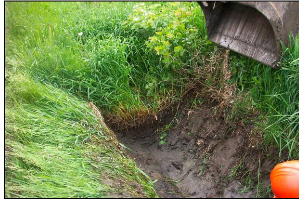
Figure 26 : Présence d'une végétation bien développée au moment du nettoyage du site no 3 à l'aide de la méthode du tiers inférieur (13 juin 2005)
