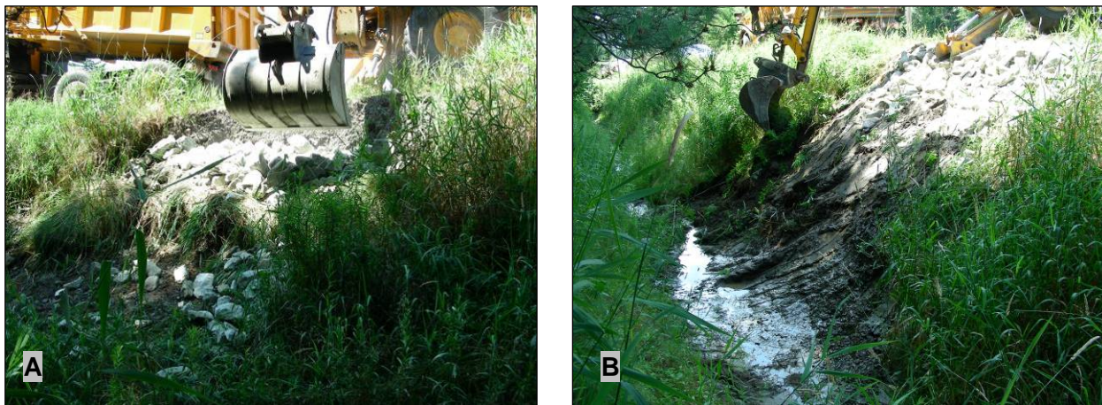
Figure 98 : Réparation du fossé du site n o 7 entre les mètres 27 et 32 (20 juillet 2006) : A) mise en place des pierres; B) utilisation des sédiments accumulés dans le fond du fossé pour couvrir les pierres et favoriser la reprise de la végétation
