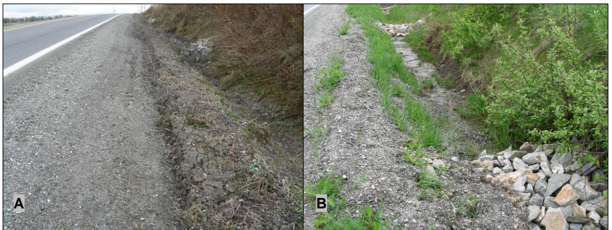
Figure 85 : Évolution du fossé du site no 4 : A) couche de gravier enlevée par un chasse-neige sur l'accotement en octobre 2005 (11 novembre 2005); B) végétation qui repousse au travers de la couche de gravier sur le talus du côté de la route (23 mai 2006)
