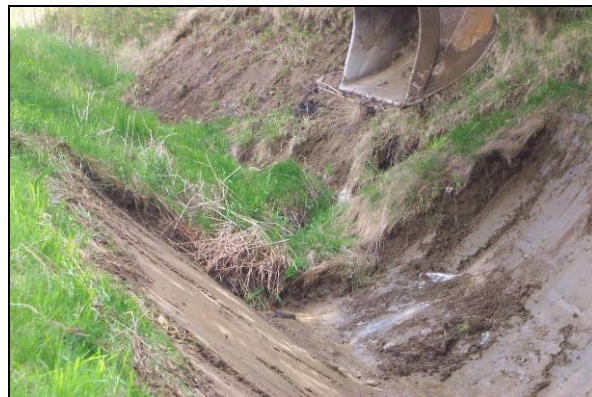
Figure 43 : Affleurement rocheux mis à nu au mètre 130 du site n° 7 lors du nettoyage (24 mai 2005)
