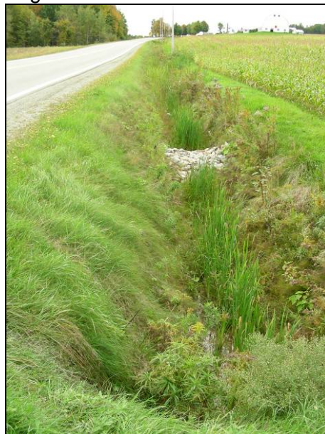
Figure 120 : Reprise de la végétation dans le fossé du site n° 14 (20 septembre 2006)
