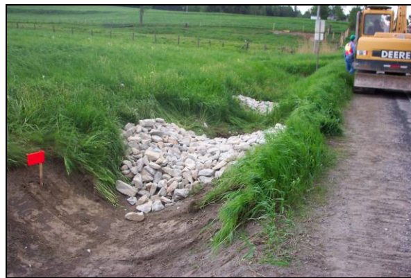
Figure 60 : Bermes filtrantes installées en aval du site n° 11 (7 juin 2005)
