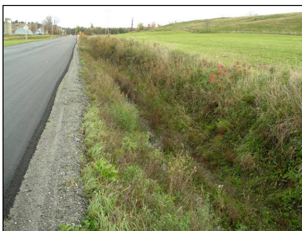
Figure 115 : Asphaltage de la route bordant le fossé du site n° 11 (13 octobre 2006)
