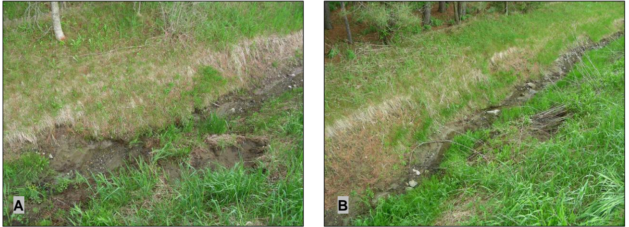
Figure 96 : Marques de décrochement dans la portion aval du fossé du site n° 7 (23 mai 2006) : A) entre les mètres 9 et 11; B) entre les mètres 27 et 30
