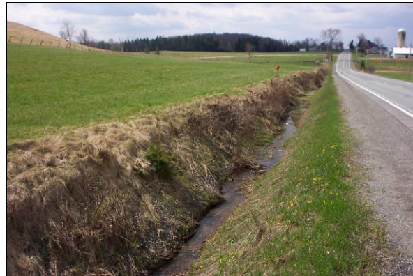
Figure 58 : Eau circulant dans le site n° 11 avant le nettoyage, à la suite de précipitations survenues quelques heures auparavant (2 mai 2005)
