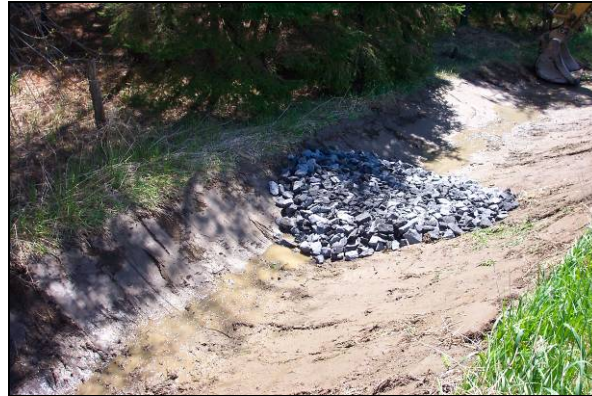
Figure 2 : Berme filtrante installée pour le site n° 7 et zone nettoyée en aval de la berme pour créer un second bassin de sédimentation (24 mai 2005)
