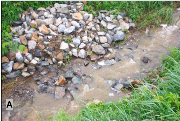
Figure 5 : État des bermes du site n° 10 à l'occasion de fortes précipitations (17 juin 2005) : A) berme n° 4 éventrée; B) berme n° 1 peu éventrée avec une importante sédimentation en amont
