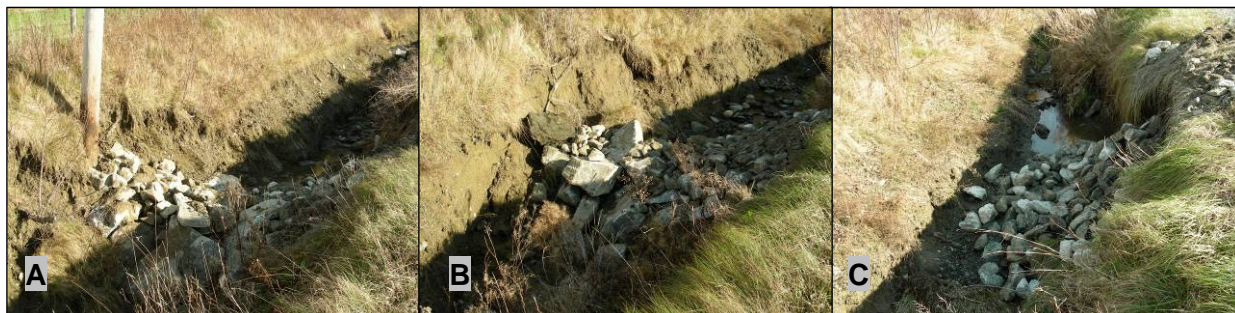
Figure 112 : Réparation de trois sections du site n° 10 (17 novembre 2006) : A) stabilisation du talus au mètre 130; B) installation d'un seuil entre les mètres 146 et 151; C) stabilisation de l'accotement entre les mètres 165 et 168
