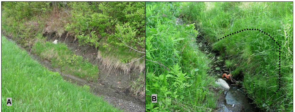
Figure 91 : Marques d'érosion dans le fossé du site n° 6 : A) décrochement sur le talus du côté opposé à la route entre les mètres 4 et 8 (23 mai 2006); B) affaissement d'une portion du talus du côté de la route à la suite de l'érosion sous le talus causée par la déviation de l'écoulement (14 juin 2006)
