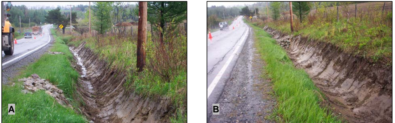
Figure 22 : État du fossé du site n° 2 au moment du nettoyage (26 mai 2005) : A) nettoyage manqué à l'aide de la méthode du tiers inférieur au mètre 30; B) fossé avec les seuils en pierres au mètre 40
