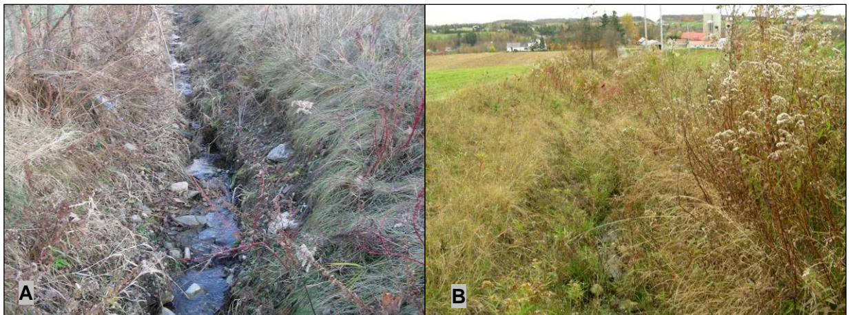
Figure 105 : Évolution du fossé du site n° 9 : A) érosion linéaire et présence de blocs dans le fond du fossé créant de l'érosion par effet de chute (21 novembre 2005); B) importante reprise de la végétation dans la portion excavée du fossé (17 octobre 2006)
