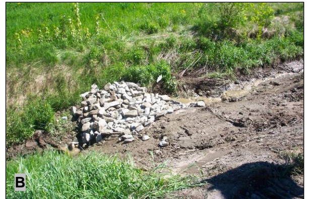
Figure 34 : Bloc de très grande dimension exhumé, au mètre 90, dans le fossé du site no 5 lors du nettoyage (1er juin 2005) : A) bloc enterré dans le talus du côté de la route; B) seuil installé pour stabiliser le bloc
