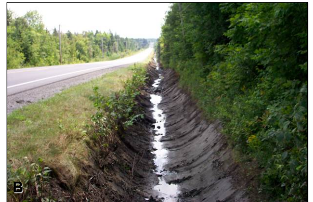
Figure 67 : Comparaison des méthodes de nettoyage au site n° 13 : A) fossé nettoyé à l'aide de la méthode du tiers inférieur au mètre 170 (9 juin 2005); B) même fossé nettoyé à l'aide de la méthode se rapprochant de la méthode traditionnelle et où les talus sont complètement dénudés (15 août 2005)
