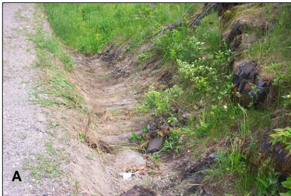
Figure 29 : Affleurements rocheux apparus dans le fossé du site no 4 au moment du nettoyage (6 juin 2005) : A) affleurement rocheux en fond de fossé et sur le talus opposé à la route au mètre 137; B) seuil en pierres au mètre 141
