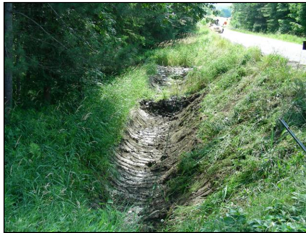
Figure 9 : Mise en place d'une seconde berme en aval du site n° 7 (20 juillet 2006)
