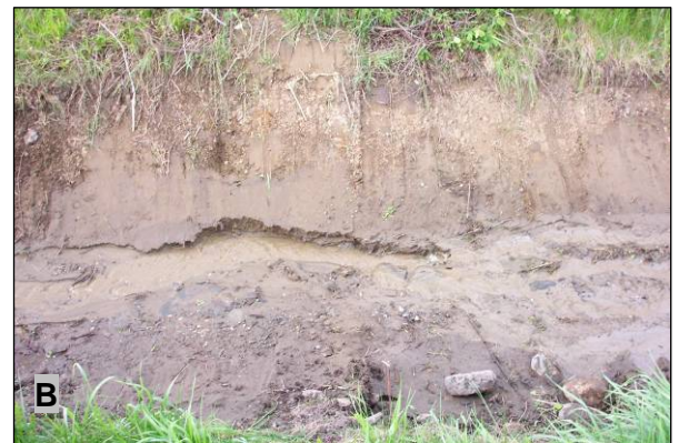
Figure 55 : Érosion rapide au mètre 9 du site n° 10 au cours de la journée du nettoyage du fossé (30 mai 2005) : A) photographie prise à 11 h 50; B) photographie prise à 15 h 55
