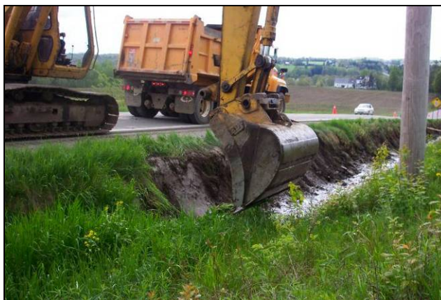
Figure 14 : Nettoyage du site n° 10 à l'aide de la méthode traditionnelle en laissant la végétation sur la moitié du talus du côté de la route (30 mai 2005)
