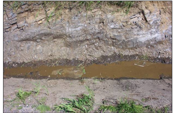
Figure 59 : Fossé du site n° 11 après le nettoyage à l'aide de la méthode traditionnelle (7 juin 2005) : A) profil transversal vu de l'aval du fossé; B) affleurements rocheux sur le talus du côté opposé à la route au mètre 37
