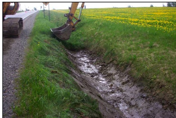
Figure 51 : Nettoyage du site no 9 au mètre 160 (31 mai 2005)
