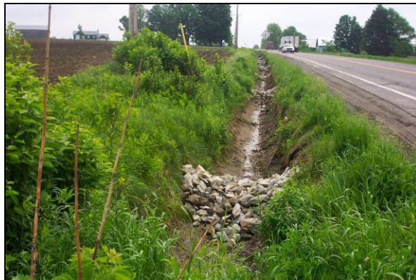
Figure 64 : Exemple d'espacement des seuils à partir du mètre 37 au site n° 12 (13 juin 2005)
