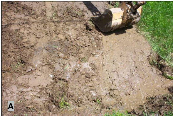
Figure 34 : Bloc de très grande dimension exhumé, au mètre 90, dans le fossé du site no 5 lors du nettoyage (1er juin 2005) : A) bloc enterré dans le talus du côté de la route; B) seuil installé pour stabiliser le bloc
