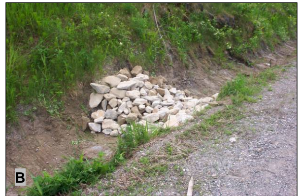
Figure 29 : Affleurements rocheux apparus dans le fossé du site no 4 au moment du nettoyage (6 juin 2005) : A) affleurement rocheux en fond de fossé et sur le talus opposé à la route au mètre 137; B) seuil en pierres au mètre 141
