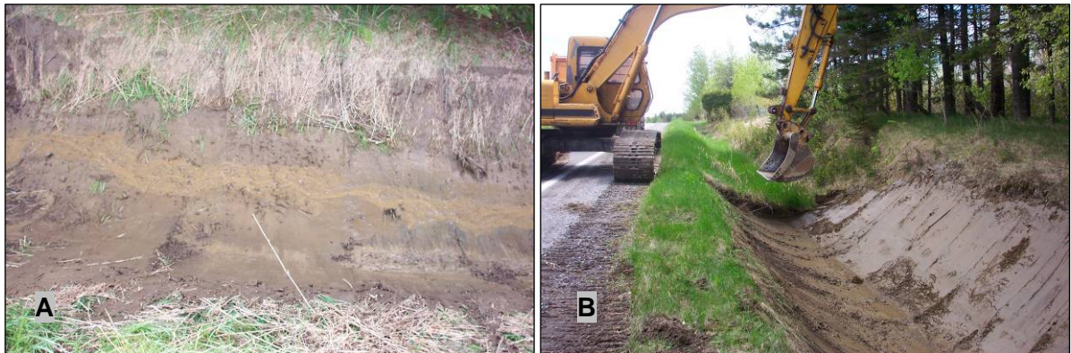
Figure 42 : Variantes de la méthode traditionnelle réalisée au site n° 7 lors du nettoyage (24 mai 2005) : A) végétation conservée par inadvertance au sommet du talus opposé à la route au mètre 87; B) bande de végétation conservée volontairement au sommet du talus du côté de la route lors du nettoyage au mètre 150 pour en préserver la stabilité
