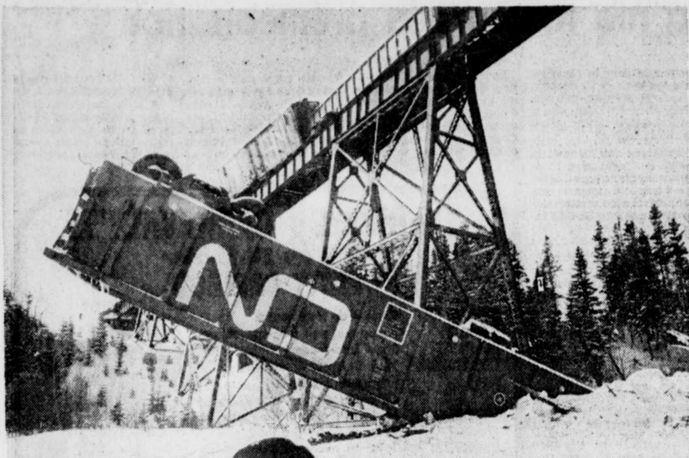
Déraillement sur le pont de la rivière de l'Anse-à-Beaufils.
