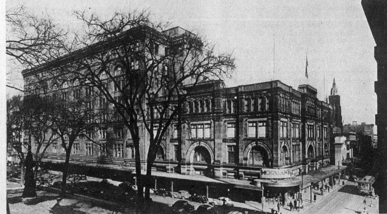
Aujourd'hui, la compagnie compte environ 250 magasins de détail de Terre-Neuve au Yukon et des Îles Arctiques à la péninsule de la Niagara. Ses activités occupent au delà de 16,000 personnes. Sur la photo on aperçoit le magasin à rayons qui changera de nom à compter de la semaine prochaine pour celui de "La Baie".
