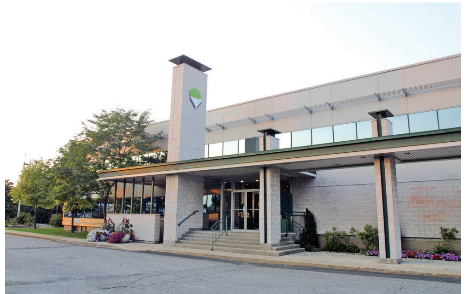
Cette subvention est destinée à la réhabilitation de conduites d'eaux usées. (Photo : archives)
