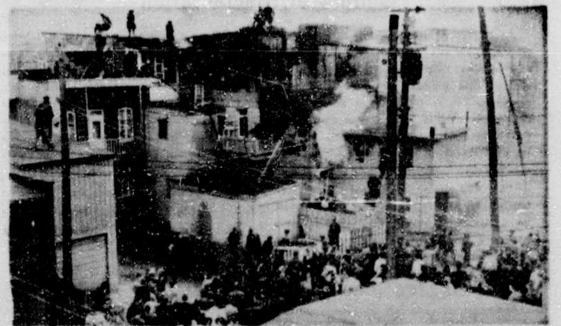
Incendie à Limoilou
