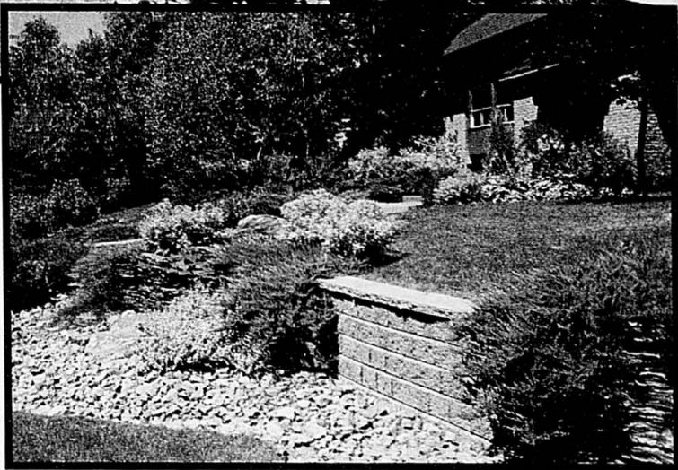
À proximité du fossé pluvial, des murets en blocs remblais à face éclatée alternent avec des rocailles. Le fossé, lui, est en partie gazonné et en partie recouvert de galets de rivière.
