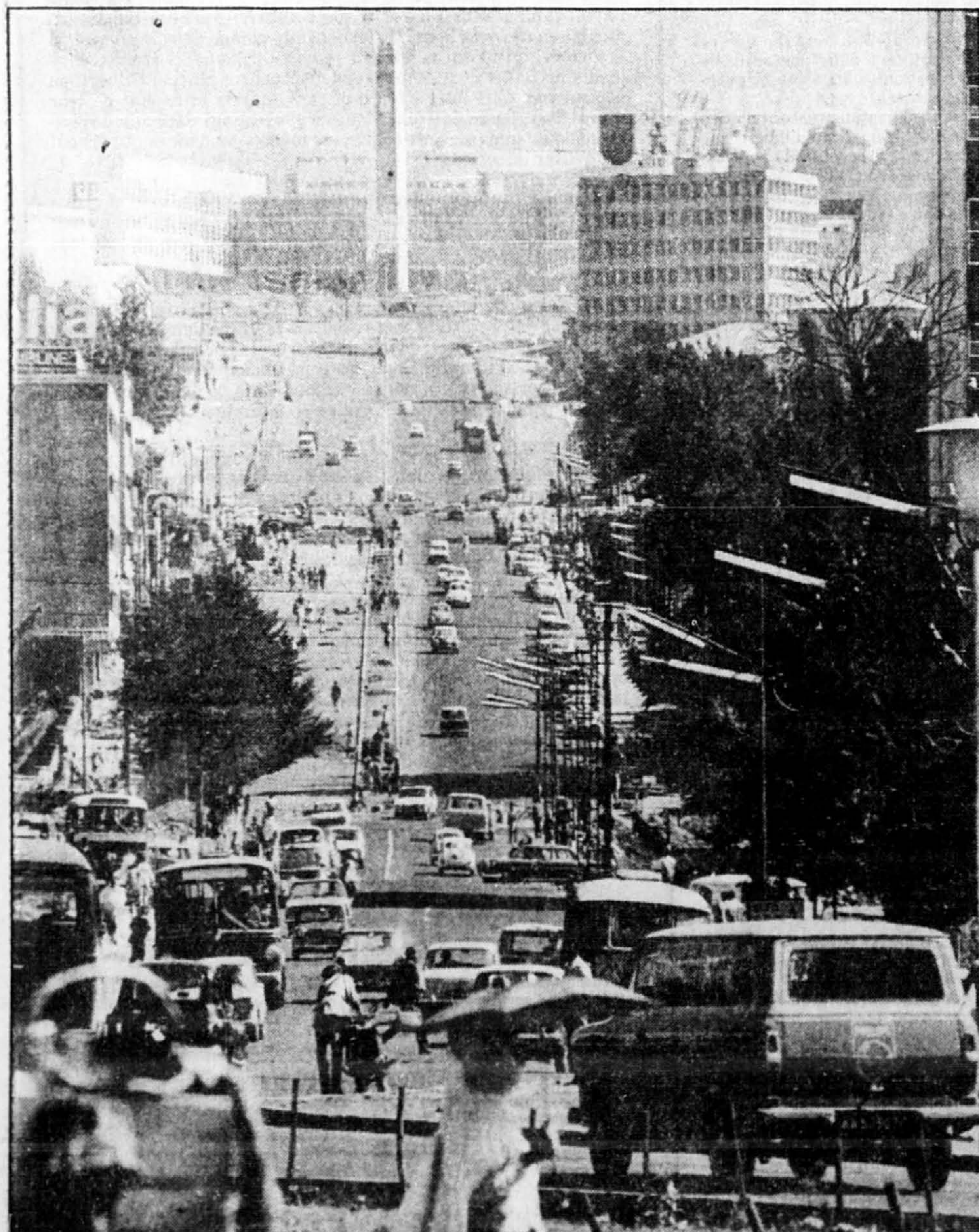
Une des rares grandes avenues d'Addis Abeba, avec, au sommet de la colline, les édifices de la Municipalité. Tout autour, les toits de tôle des bidonvilles.
