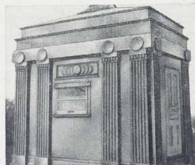
*Le toit de la cage de l'ascenseur est protégé et embelli par des tôles de cuivre Anaconda.*
