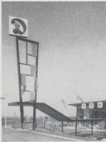
Détail de l'enseigne, au niveau du boulevard St-Joseph.
