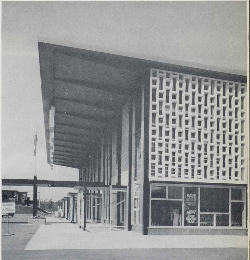
Vue fuyante de façade.
