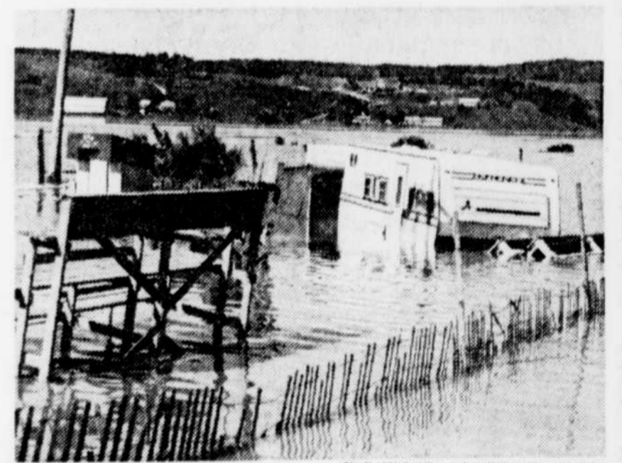
Le terrain de jeux de Saint-Joseph a subi des dommages importants.
