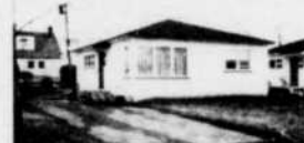
248, rue Simard, Arvida, bungalow, 27 x 36, (3 chambres), terrain, 50 x 100, aménagé, entrée asphaltée. Dossier 1440.
