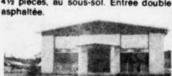
Split-level, 36 x 26 p. c., 4 1/2 pièces, (grandes), terrassement fait, situé, rue Elie, Chic.-Nord.
