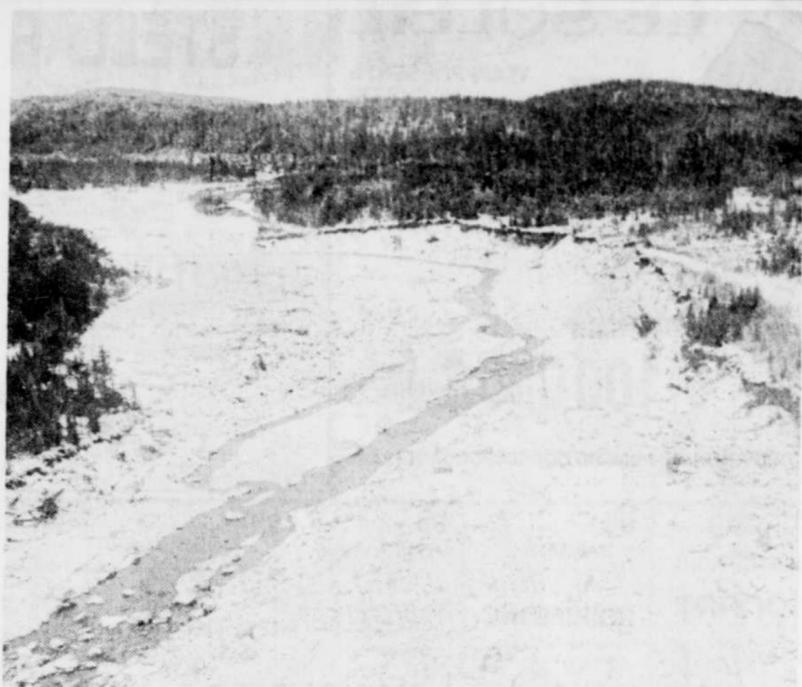
Le mince filet d'eau, au centre de la photo, indique le lit normal de la rivière Beloeil. Les rives, recouvertes de neige, indiquent bien l'érosion causée par la rupture du barrage de terre de 4 mètres de hauteur, en septembre 1985.
