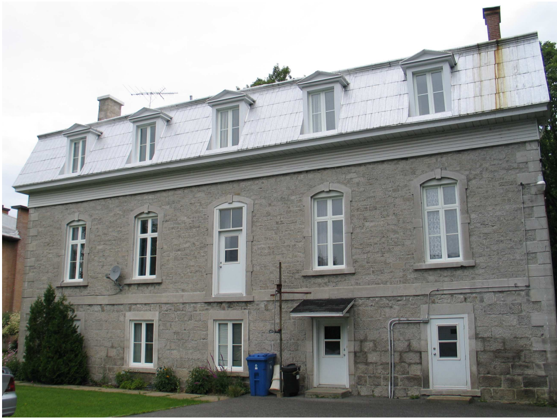
Deuxième presbytère de Sainte-Élisabeth bâti en 1873. (Vue arrière)
