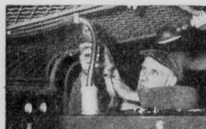
Installant le câble de raccordement avec le panneau d'éclairage.
