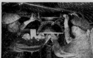
Fixant des feux d'éclairage sur une grille en fils métalliques pour sécurité dans le transport.
