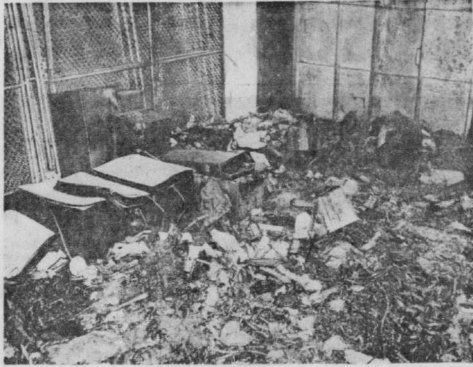
INCENDIE DANS LE PORT DE QUÉBEC — Un incendie, qui fut rapidement maîtrisé, a détruit une petite cabane servant d'abri au veilleur de nuit. La cabane a été rasée ainsi que des marchandises qui s'entassaient à proximité. Un vaste entrepôt a également subi quelques dégâts. Au début de ce feu, le gardien P.-E. Lavoie, 283 rue Champlain, a été foudroyé par une crise cardiaque.
