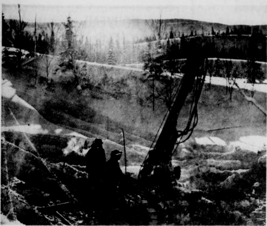
LA CONSTRUCTION de deux lignes de transport d'énergie à 230 kV progresse rapidement malgré la neige et le froid rigoureux à l'aménagement hydro-électrique de Churchill Falls. La plupart des 176 pylônes en V haubonnés sembleraient à ceux des lignes à 735 kV de Churchill Falls, mais
