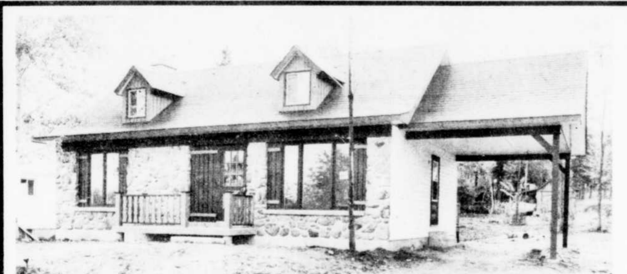
RUE DES TILLEULS - Style canadien, façade en pierres de champs, 5 pièces, armoires en merisier. (Le terrassement a depuis été terminé)
