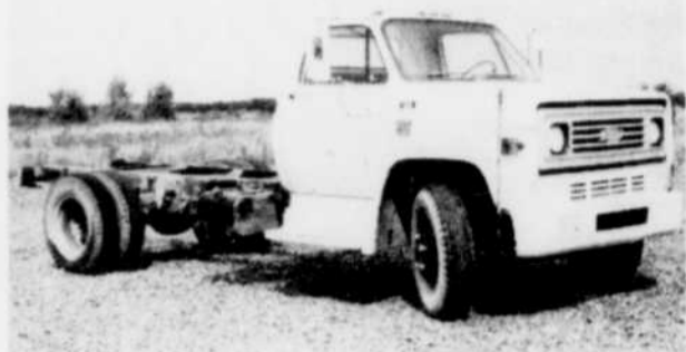
Camion Chevrolet 76, moteur 350, essieu avant 5,000, essieu arrière 15,000; 36,000 milles.
