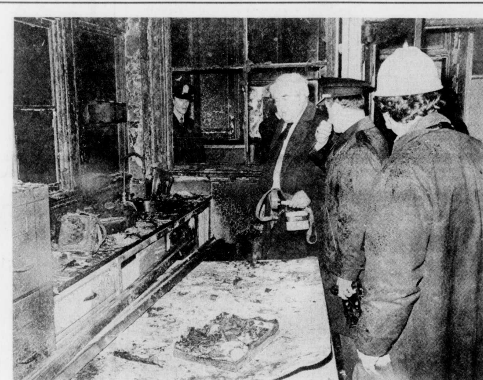
C'est dans cet atelier, une classe de l'ancienne crèche de Saint-Vincent-de-Paul, que travaillaient les handicapés qui ont été tués ou blessés par l'explosion. (Photo André Belleisle)
