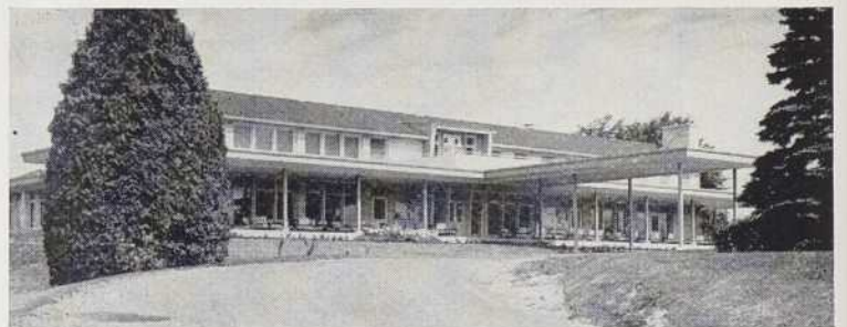
Vue en façade, du chemin des automobiles.
