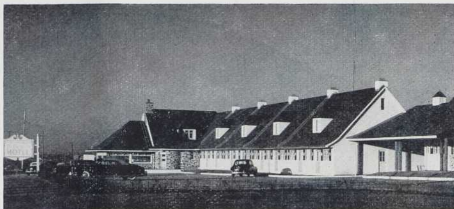
La partie comportant un étage. A droite, entre les deux bâti- ments, l'entrée du stationnement de l'arrière.
