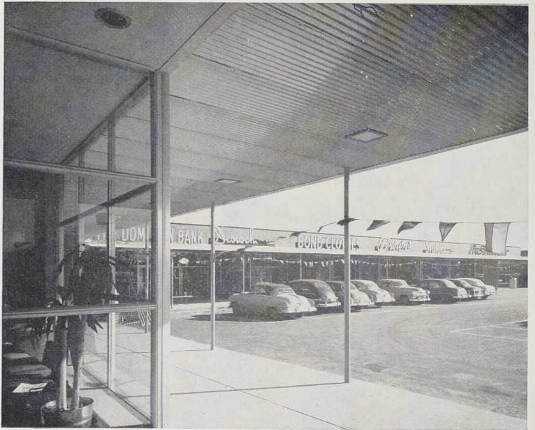
Vue des groupes de magasins à partir de la salle de repos de l'épicerie Steinberg's, à gauche.
