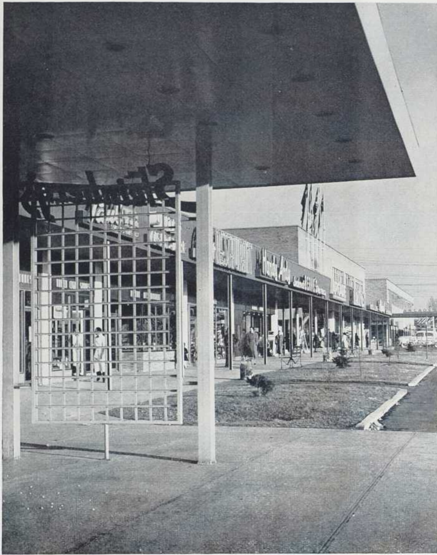
Vue sous la marquise vers l'arcade où sont situés les plus petits magasins.
