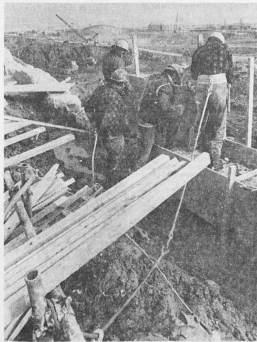
Occupés à faire une finition au mur d'une cinquantaine de pieds de hauteur, ces employés doivent solidement s'attacher à une rampe de sécurité, en cas de chute malencontreuse.
