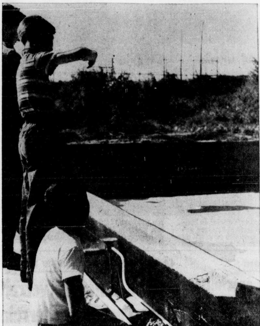
DANS L'ATTENTE de leur piscine, ces trois garçons de Shawinigan-Sud ont déjà commencé à faire des projets pour perfectionner leur manière de nager... La piscine en construction présentement sur le terrain de l'OTJ sera terminée au début de juillet.
