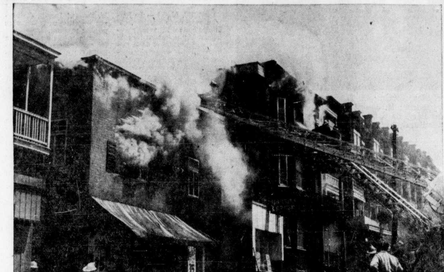
INCENDIE RUE CARTIER — Un désastreux incendie a ravagé une maison de rapport, une épicerie et un logement situé au deuxième étage et a fortement endommagé une teinturerie, hier après-midi, rue Cartier, à Québec. On voit ici les pompiers combattant les flammes.
