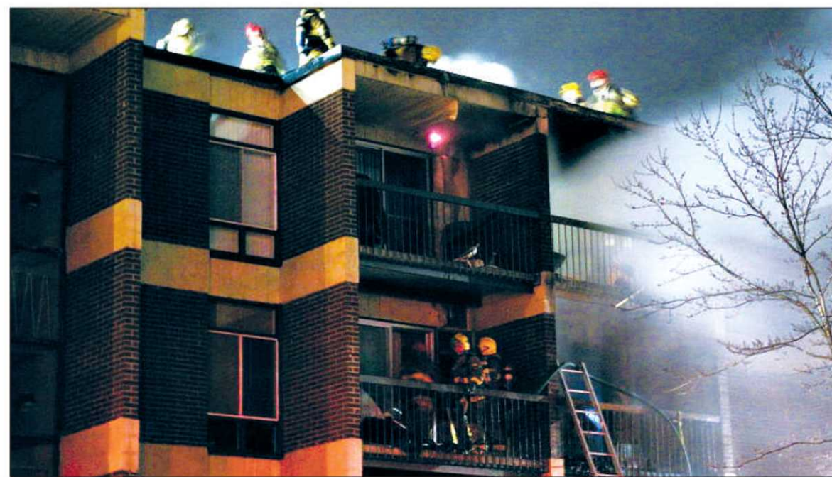
Une cigarette jetée dans un pot à fleurs a déclenché un incendie qui a gravement endommagé un immeuble de logements situé le long du boulevard du Versant-Nord. — PHOTO BERNARD BOULET
