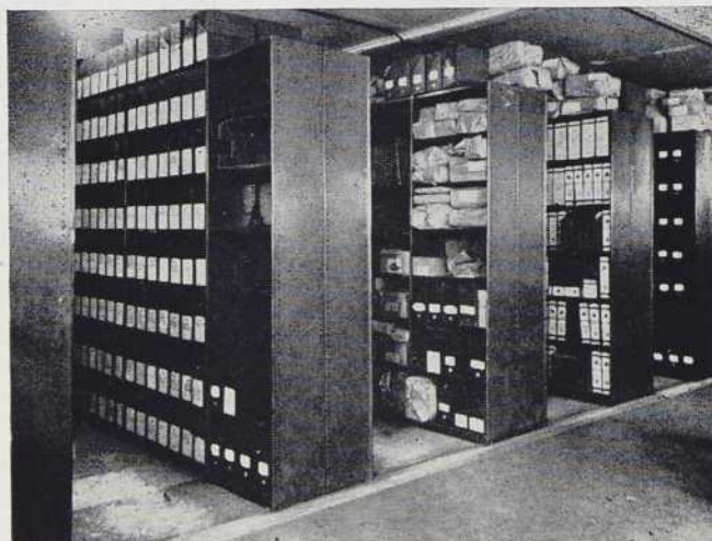
Installation de rayonnages en acier.
