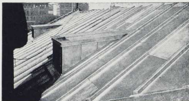
Vue du toit en Monel du bureau de poste d'Halifax, au moment où on le terminait. Entrepreneurs: D. A. Cummings Limited, Halifax, N.-E.
