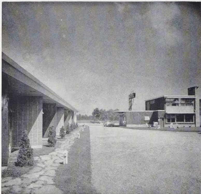
Détail des cabines placées en "dent de scie". A droite, l'administration et le logement. A l'arrière-plan, la route Montréal-Ottawa et Montréal-Toronto. Autre vue des mêmes cabines au bas de la page.
