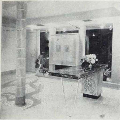
Détails du comptoir de marbre sur base de bois et de cuivre, de l'arrière de la montre et de la colonne. La composition est simple, l'exécution parfaite.
