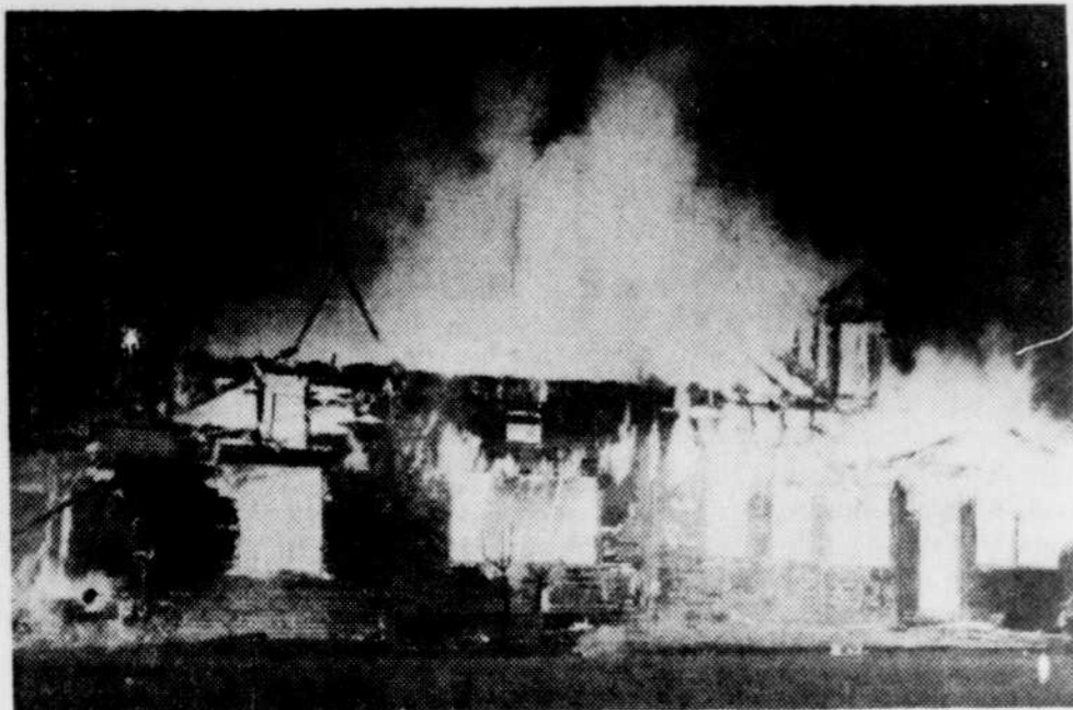
La maison plus que centenaire de la famille Heath, demeurant près de la route 5 à Stanstead-Est, quelques instants après le début de l'incendie qui a complètement ravagé cet immeuble. (Photo La Tribune, Studio Pépin, Rock Island)
