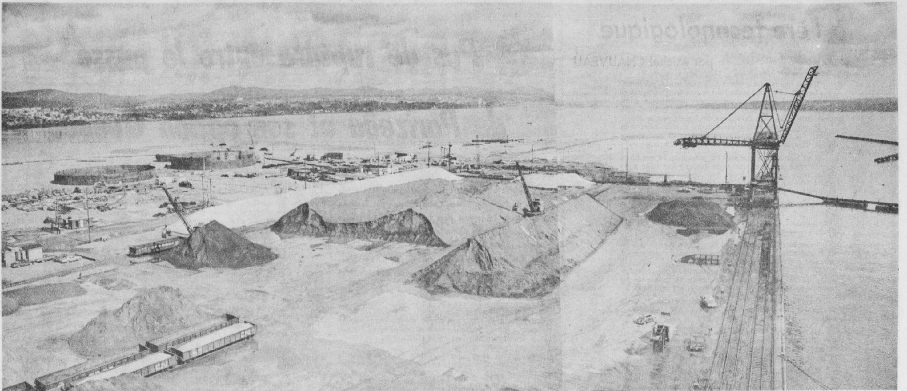
Les travaux de remplissage des battures de Beauport progressent
