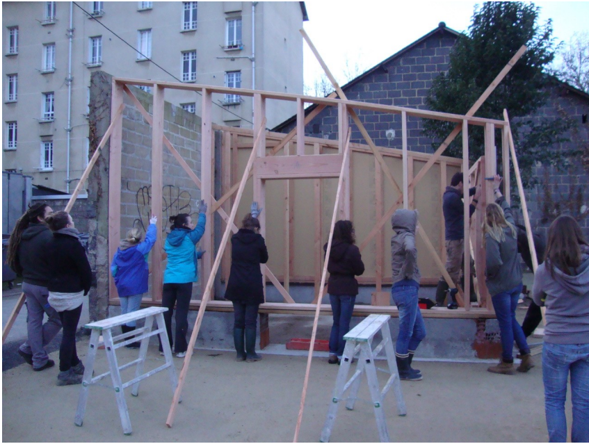
Figure 2. Montage d'une ossature en bois, à l'ENSAB, 2016. Enseignement de Rozenn Kervella (ENSAB) © Rozenn Kervella
