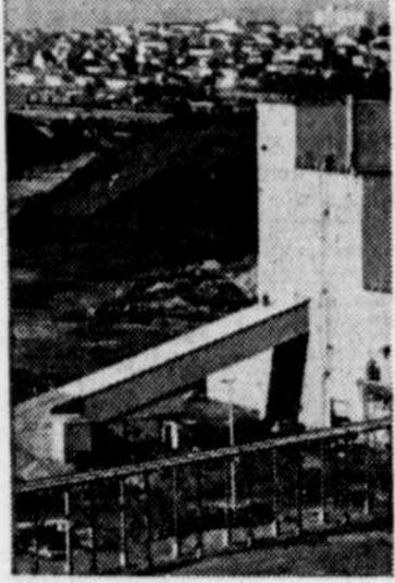
L'usine de l'Iron Ore.
