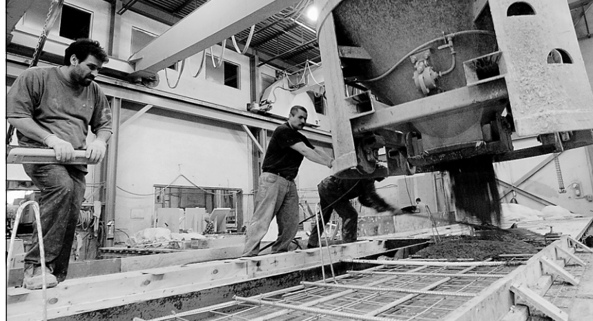
Des bennes montées sur rails envoient du béton frais à l'intérieur des moules. Il n'est pas plus difficile de produire des panneaux pesant des tonnes que de concocter un gâteau dans sa cuisine.
