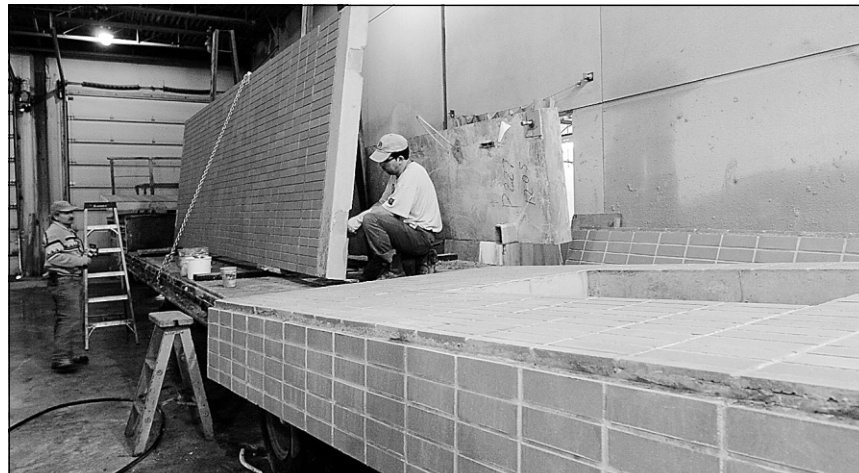
Des panneaux de béton préfabriqué parés de briquettes sont déposés sur des fardiers pour être transportés aux États-Unis.
