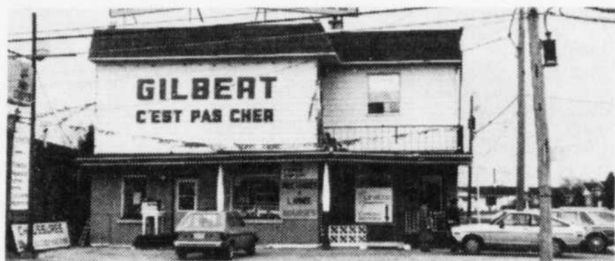
Cette façade cache un magasin de trois étages, où les clients trouveront un choix incomparable de chaussures.
