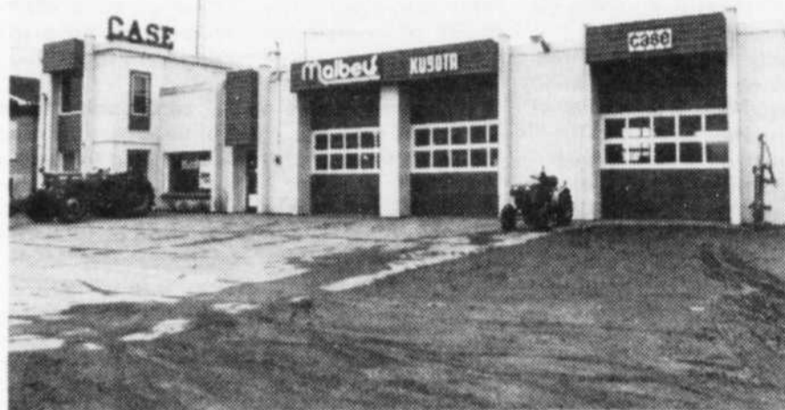
Situé en bordure de la route 138, à l'entrée de Louiseville, Malbeuf Équipements est facilement accessible pour les agriculteurs et les entrepreneurs.
