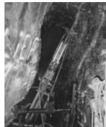
Photo : Techni Drill Inc.
