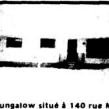
Bungalow situé à 140 rue Mo- rissette, Princeville
