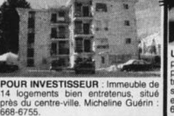
POUR INVESTISSEUR : Immeuble de 14 logements bien entretenus, situés près du centre-ville. Micheline Guérin 668-6755.
