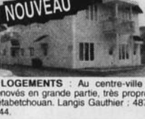
4 LOGEMENTS Au centre-ville. Rénovés en grande partie, très propre. Métabetchouan. Langis Gauthier : 487- 1144.
