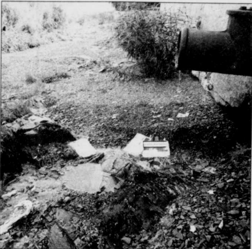
À cause des déversements, « quand la marée est basse, les gens qui se promènent ont affaire à des senteurs », déplore vertement le maire de Saint-Michel-de-Bellechasse, Denis Breton
