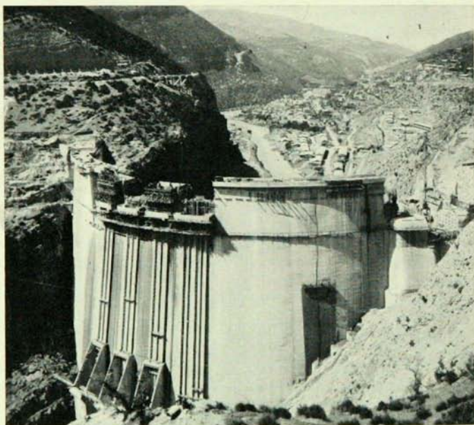
Barrage de Bin-el-Ouidane (Maroc) Bin-el-Ouidane Dam (Morocco)
