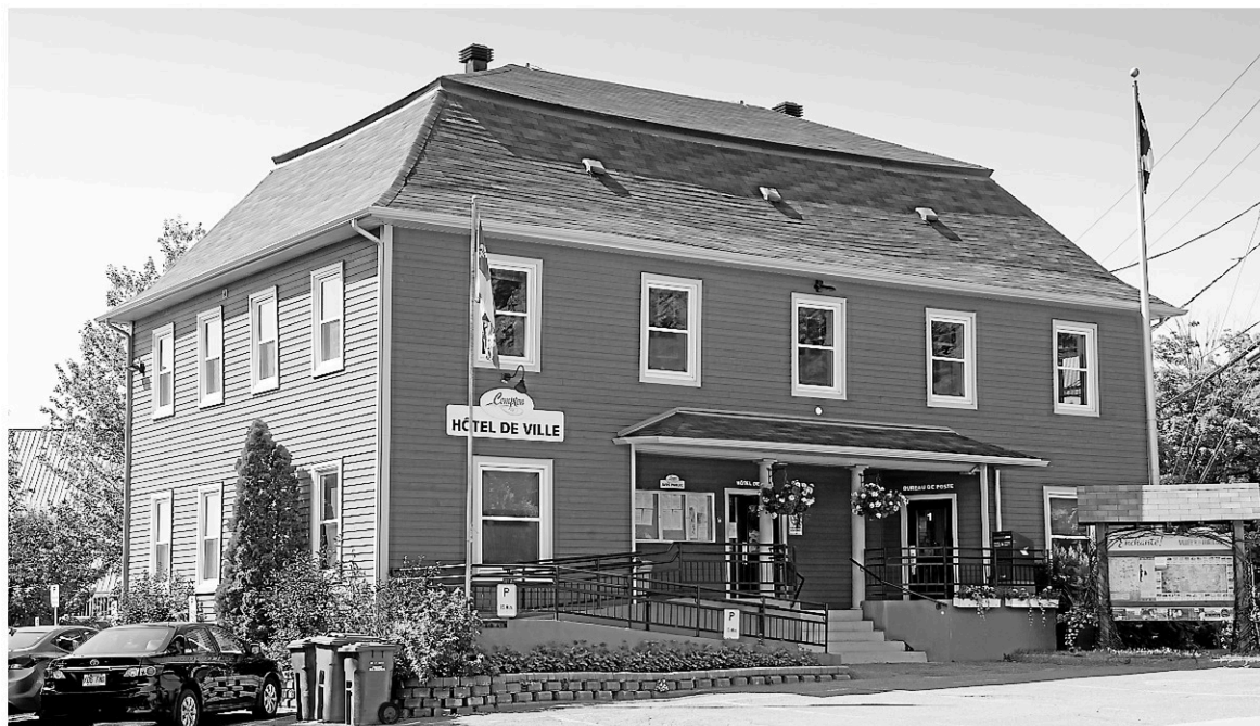
Un groupe de citoyens s'en remet à la Cour supérieure pour empêcher la démolition de l'hôtel de ville de Compton. Il conteste la validité d'une étude indiquant qu'il était dangereux et qu'il coûterait plus cher de le rénover que d'en construire un nouveau. — PHOTO LA TRIBUNE, ARCHIVES, JESSICA GARNEAU
