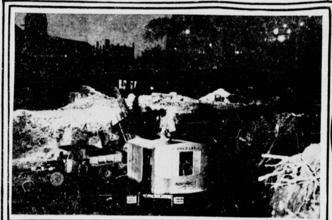
Cette seule photographie, prise durant la nuit, montre comment les travaux aux termini du Canadian National se poursuivent sans interruption. Au premier plan, une pelle à vapeur en état de fonctionnement et, à l'arrière, l'édifice de la Saint-Léon, en construction, et la silhouette des statues des apôtres sur le fronton de la cathédrale. (Photo Canadian National.)
