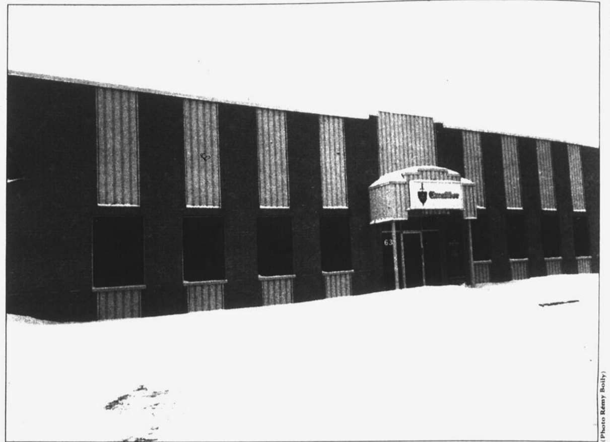
En 2004, Excalibor s'était installée dans cette usine du boulevard Industriel.
