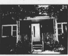
3 ch., garage isolé, abri d'auto, tout briques
