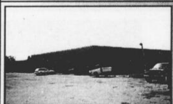
Près de l'autoroute 20, bâtisse industrielle de plus de 14,000 p.c.
