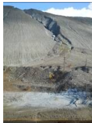
Figure 6 Écoulement préférentiel, Halde de la mine Black Lake
