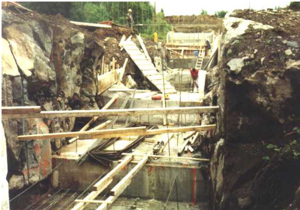
1. Excavation de première classe en paliers
