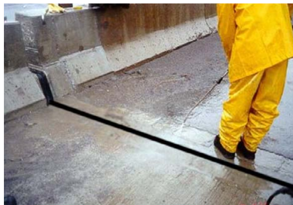
10. Essai d'étanchéité d'un joint de tablier
