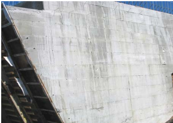
37. Béton décoffré avant correction des surfaces
