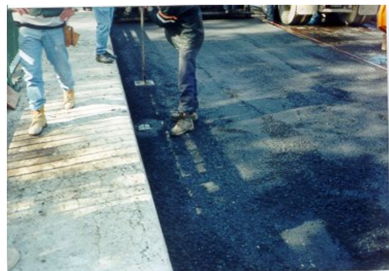
6. Compactage près d'un drain
