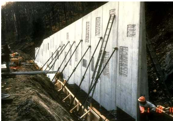
5. Mur en porte-à-faux en béton armé préfabriqué
