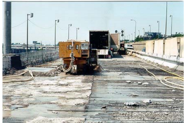
6. Hydrodémolition sur dalle
