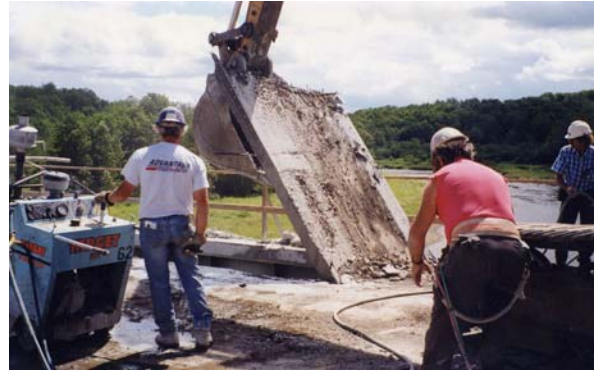
2. Enlèvement des parties de dalle sciées
