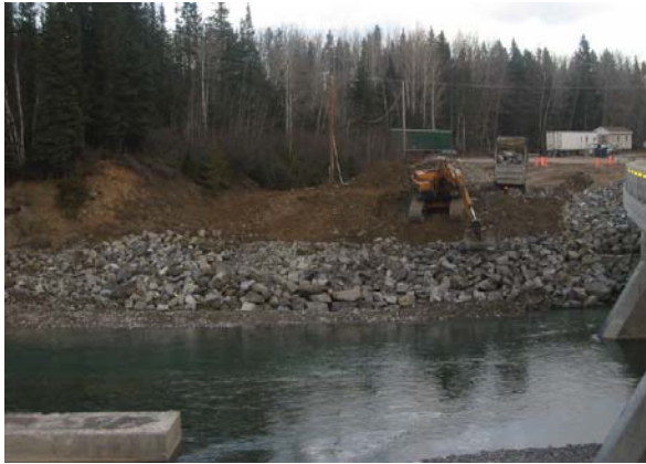
1. Mise en place de pierres avec une pelle hydraulique
