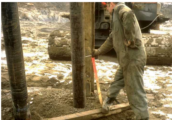
15. Mesure de l'enfoncement d'un pieu battu
