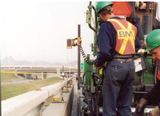
3. Mise en place de la couche de correction (avec guide)
