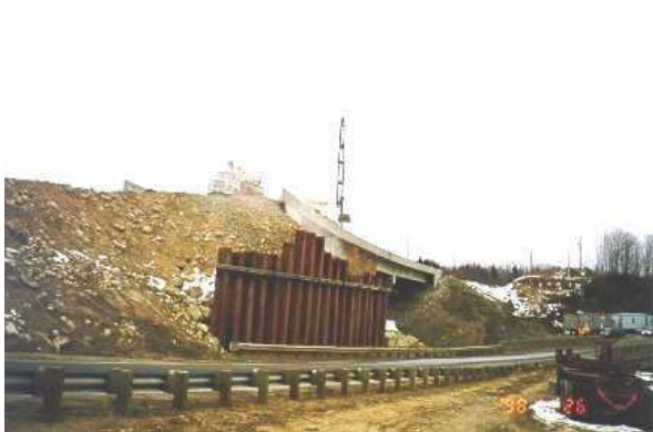
17. Soutènement temporaire en palplanches métalliques
