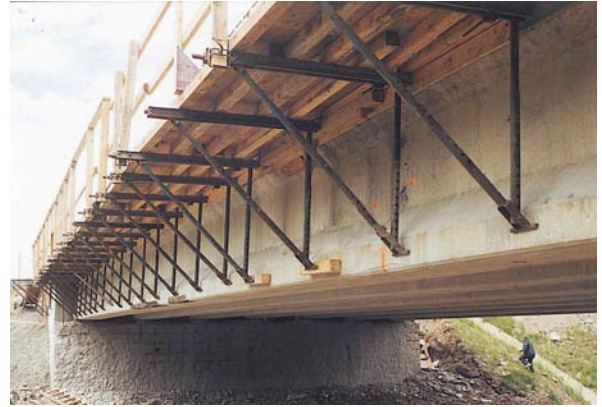
8. Supports de coffrages de dalle en porte-à-faux
