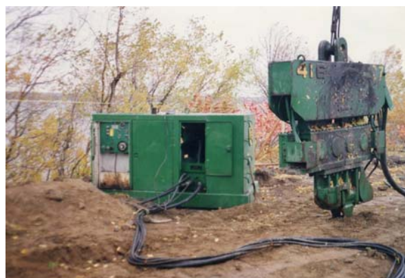
10. Vibrofonceur utilisé pour le fonçage des palplanches métalliques
