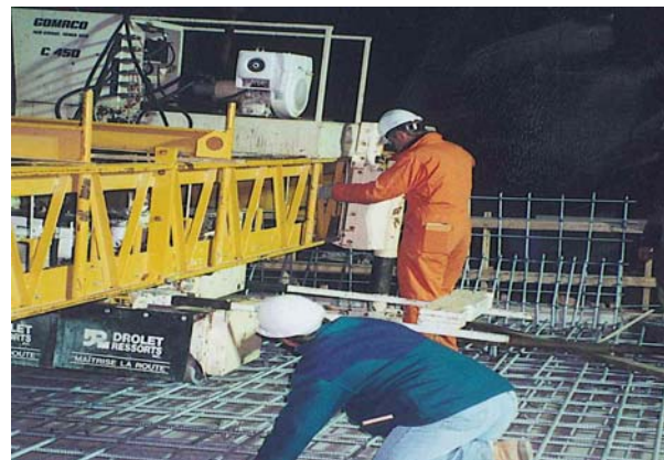
30. Ajustement du finisseur à béton automoteur
