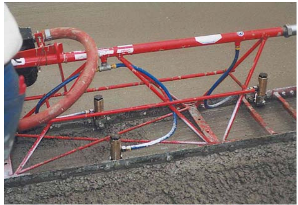
32. Détail de la règle vibrante
