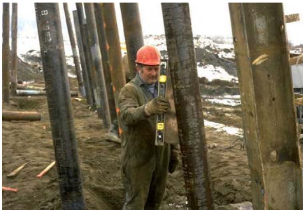
13. Contrôle de la pente des pieux battus
