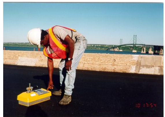
10. Mesure de la compacité au nucléodensimètre
