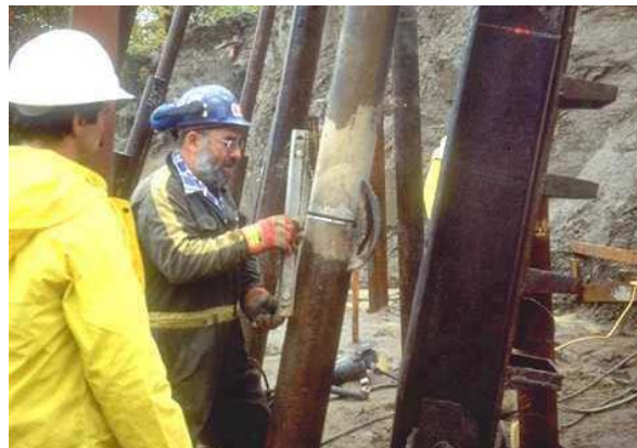
14. Contrôle de l'alignement au niveau d'un joint soudé
