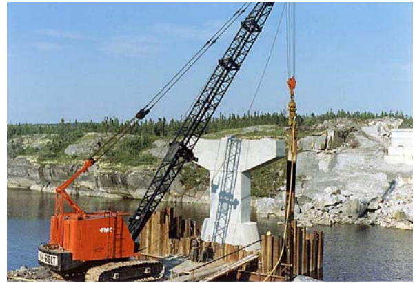
14. Enlèvement des palplanches métalliques
