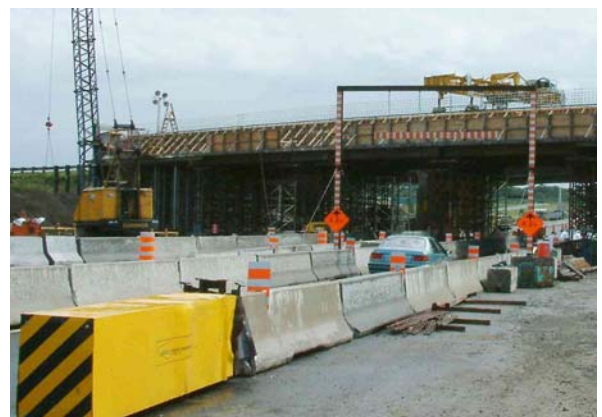
12. Protection d'étalement avec gabarit et glissières
