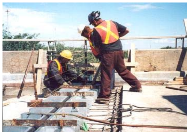
8. Mise en place d'un joint de tablier
