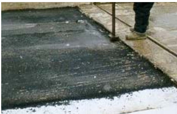
5. Compactage près d'un joint de tablier
