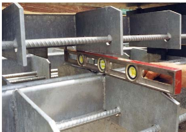
7. Vérification d'un joint de tablier (torsion)
