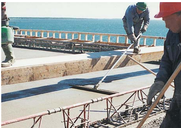
33. Finition de la dalle sur plate-forme
