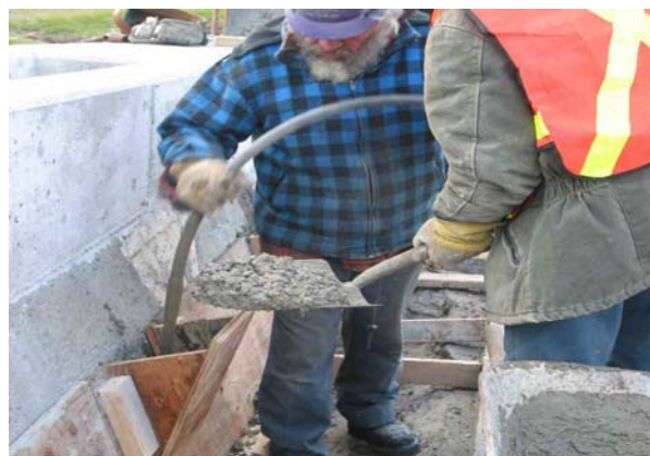
24. Insertion du vibreur dans les ouvertures de coffrage (réparation)
