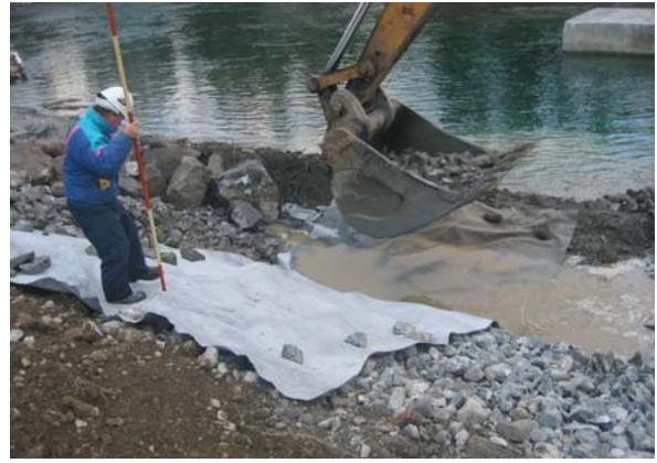
2. Mise en place d'un géotextile sous le revêtement en pierres
