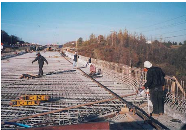
27. Vérification du profil final du rail de roulement
