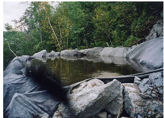
16. Bassin de sédimentation
