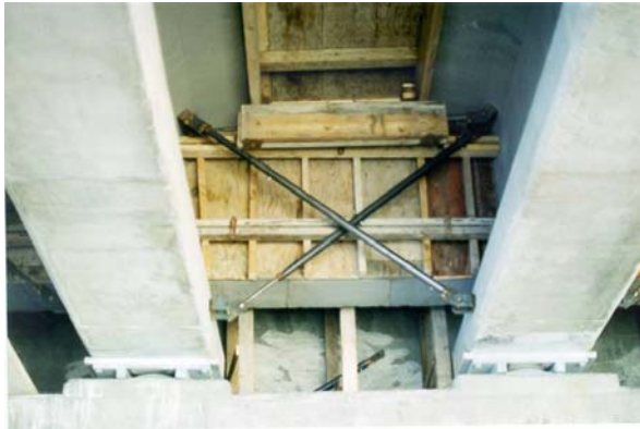
7. Contreventement temporaire pour poutre préfabriquée
