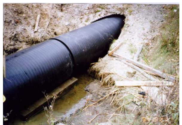
6. Insertion d'un tuyau en polyéthylène à l'intérieur d'un tuyau en tôle ondulée
