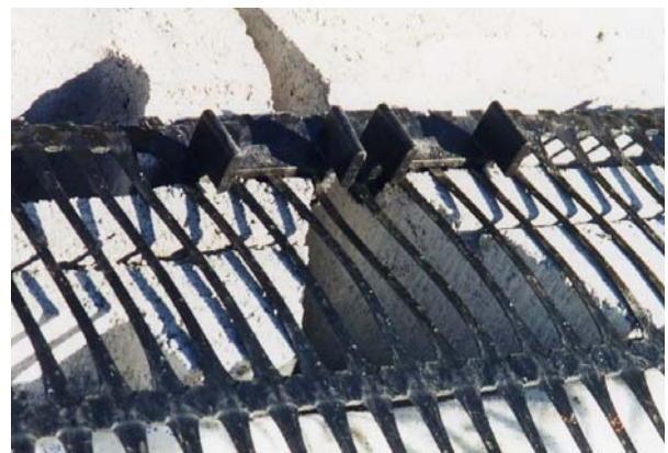
4. Connexion mécanique des géogrids aux blocs remblai
