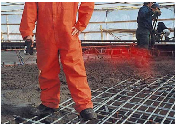
39. Prise de température des surfaces de contact (thermomètre infrarouge)
