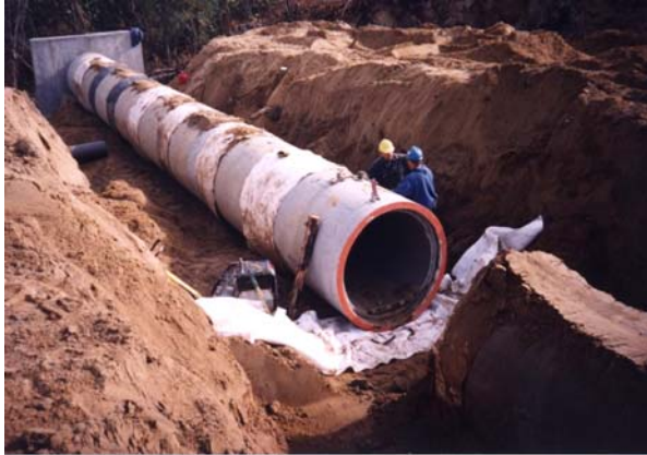
1. Installation d'un tuyau en béton armé (TBA)
