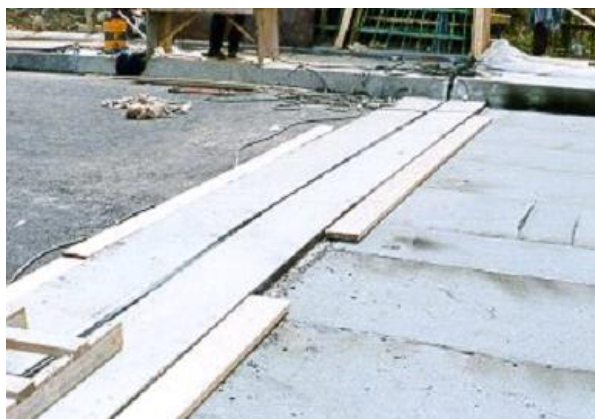
11. Protection des épaulements d'un joint de tablier après décoffrage
