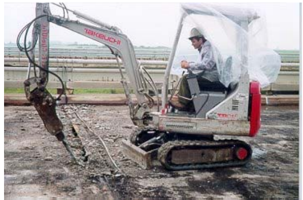
4. Enlèvement de parties métalliques de joint avec marteau hydraulique 200 J
