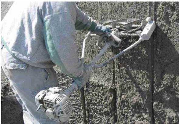
9. Arasement de la surface de béton
