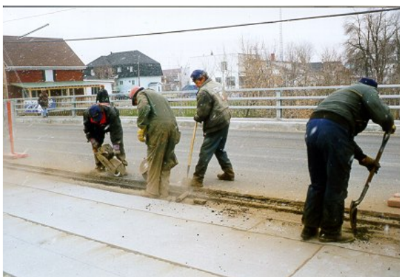
11. Sciage d'un joint froid (travaux en phases)
