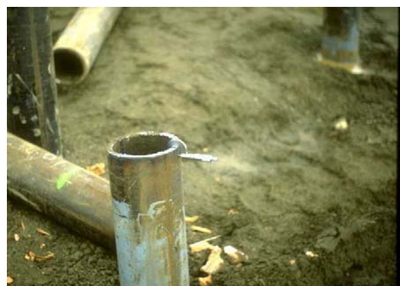
12. Mesure de l'épaisseur d'un pieu tubulaire en acier
