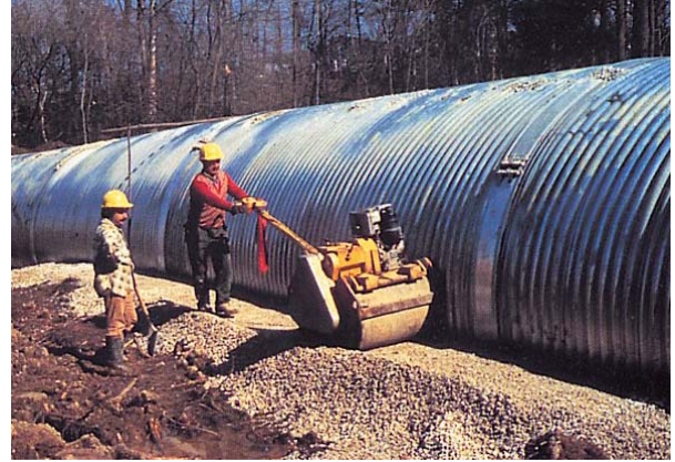
2. Compactage au début de la construction d'un tuyau en tôle ondulée aluminisée
