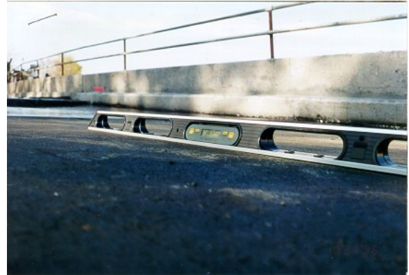
8. Vérification de profils avec niveau électronique
