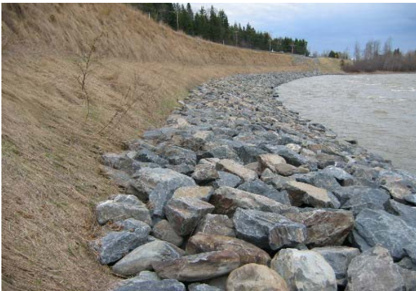
5. Perré pour la protection d'une berge
