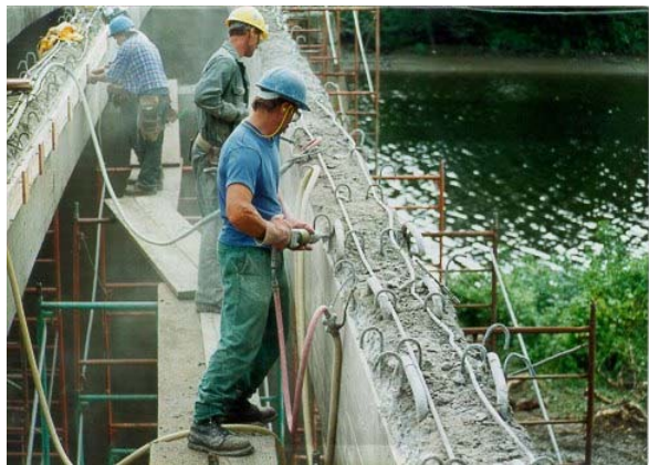
3. Démolition partielle avec marteaux pneumatiques 7 kg
