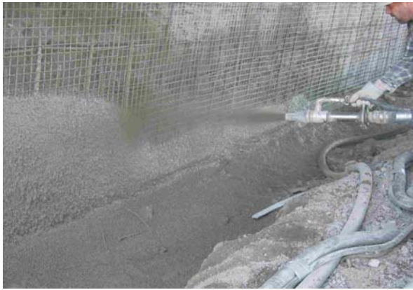
7. Technique de projection adéquate
