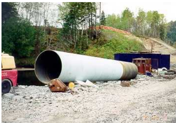
3. Pieu caisson (tube métallisé)
