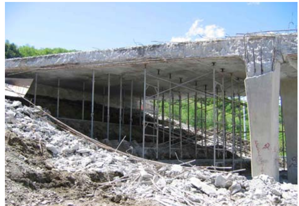
10. Étalement (travaux d'entretien)
