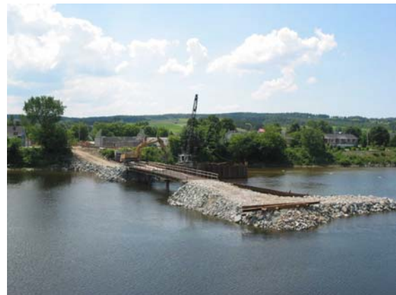
6. Chemin d'accès avec pont temporaire
