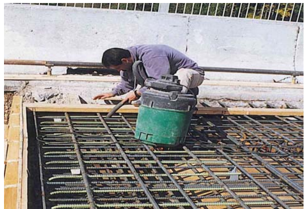
18. Nettoyage final des coffrages
