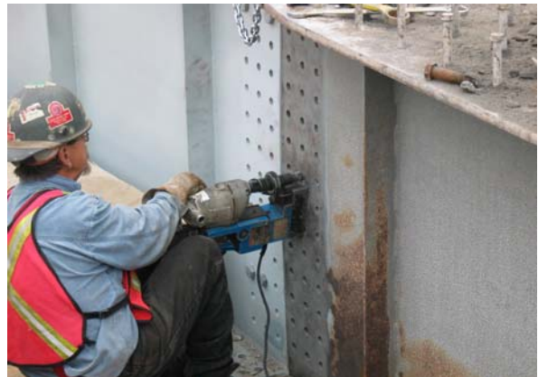
6. Perçage à la mèche avec gabarit (perçuse magnétique)
