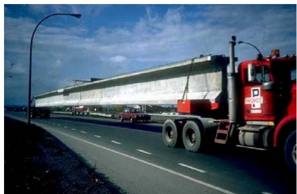
11. Transport d'une poutre préfabriquée
