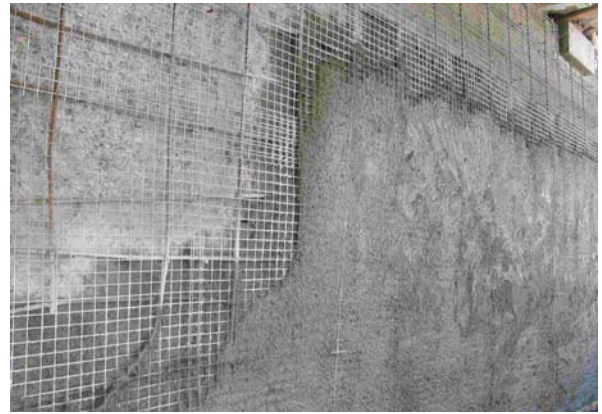
8. Travaux de projection en cours de réalisation
