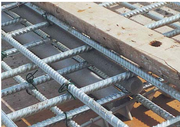
35. Boudins pour joint de construction d'urgence
