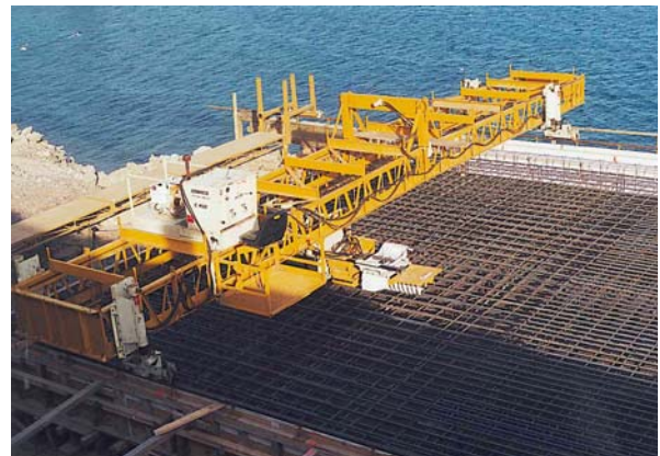
28. Finisseur à béton automoteur
