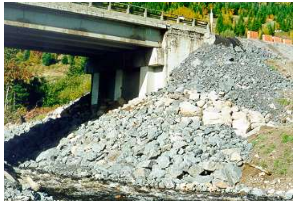
6. Revêtement en pierres sur un remblai d'approche
