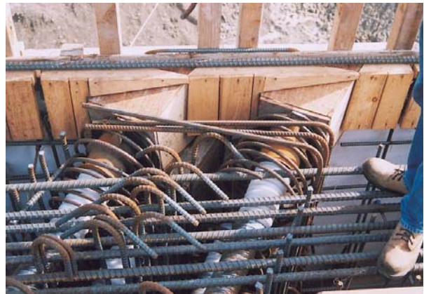
4. Armature de frettage
