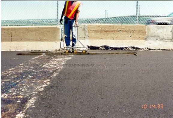
7. Vérification du profil vis-à-vis d'un joint de tablier (règle de 3 m)
