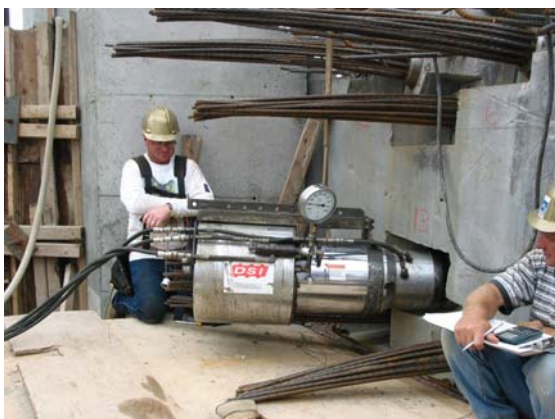
5. Mise en tension des câbles de précontrainte
