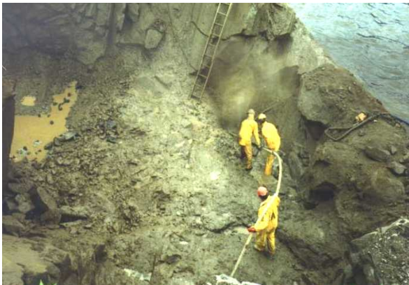
3. Nettoyage de la surface du roc
