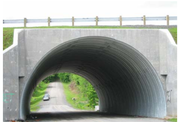
4. Tuyau voûté en tôle ondulée galvanisée sur semelle en béton
