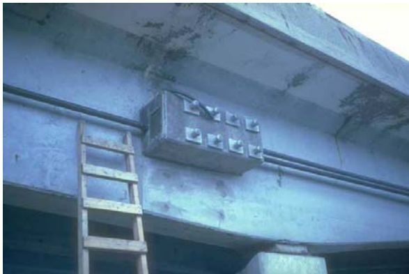
9. Précontrainte extérieure (renforcement)
