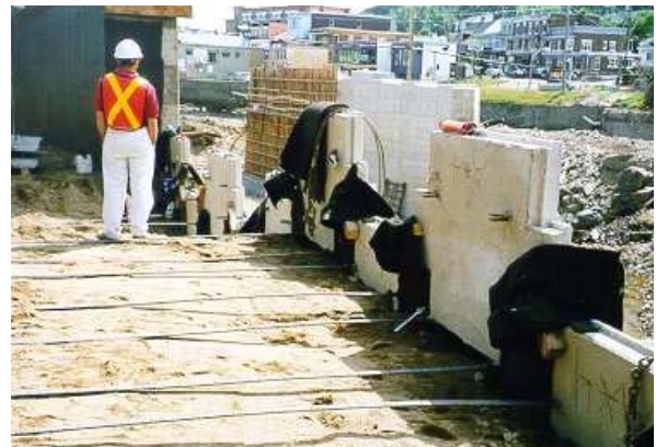
6. Mur remblai renforcé par des armatures en acier avec paroi en béton armé
