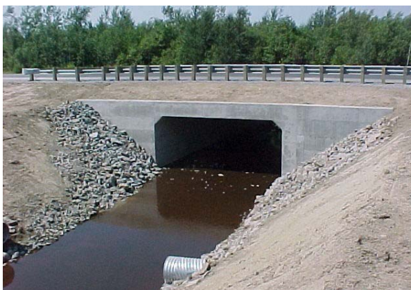
5. Ponceau rectangulaire en béton armé
