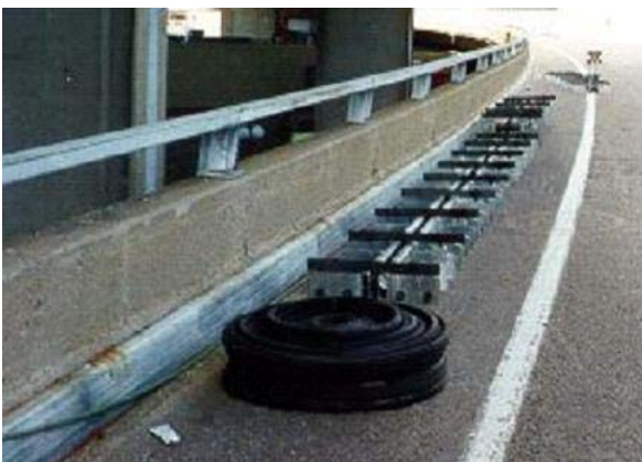
5. Entreposage adéquat d'un joint de tablier et de sa garniture d'étanchéité
