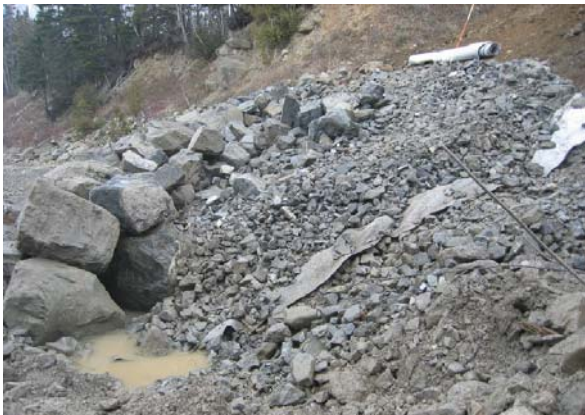
3. Revêtement en pierres lors de la construction
