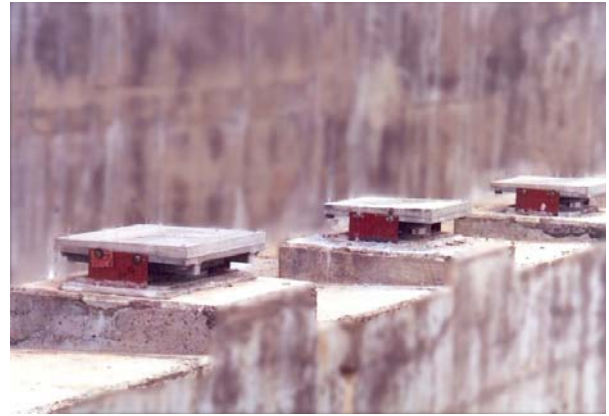
2. Appareils d'appui à élastomère confiné (guidés) sur blocs d'assise
