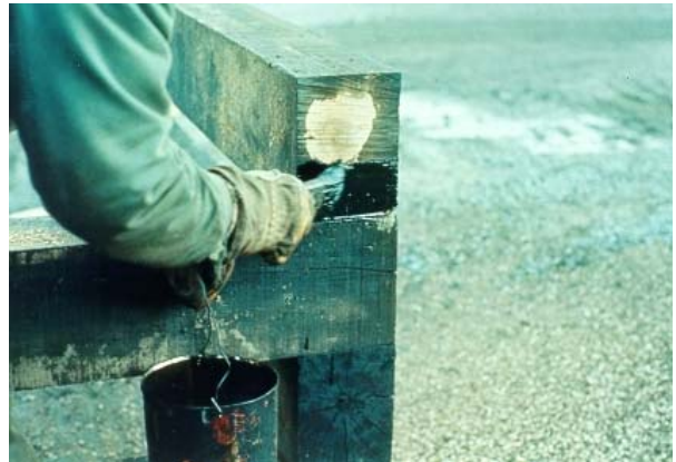
4. Badigeonnage de préservatif à la suite d'une coupe effectuée en chantier
