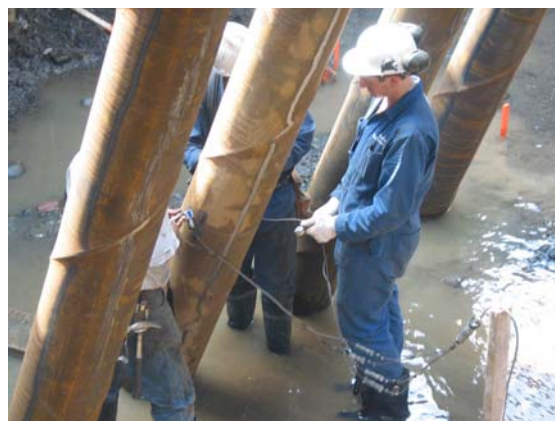
16. Instrumentation d'un pieu pour l'essai dynamique
