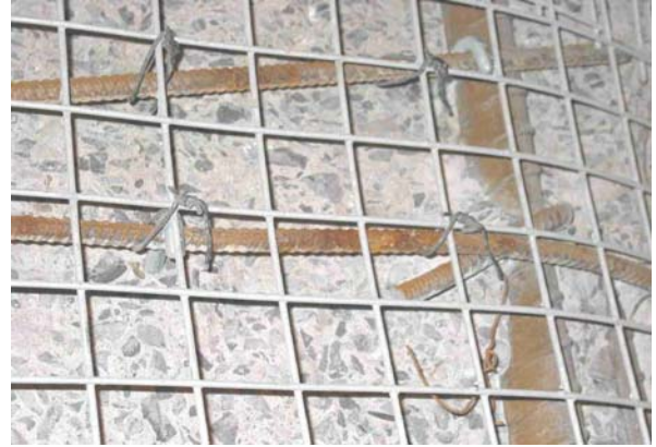
2. Fixation du treillis métallique
