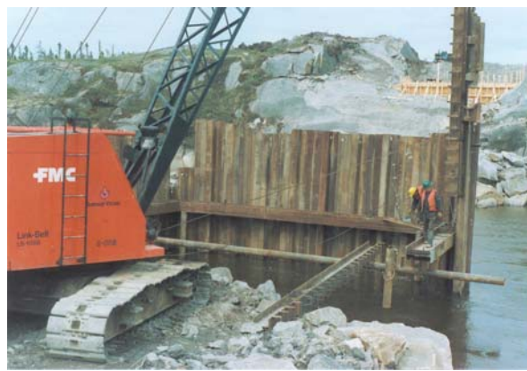
12. Fonçage de palplanches métalliques à l'aide d'un marteau
