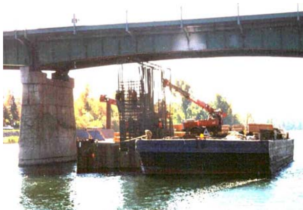
7. Accès à partir d'une barge
