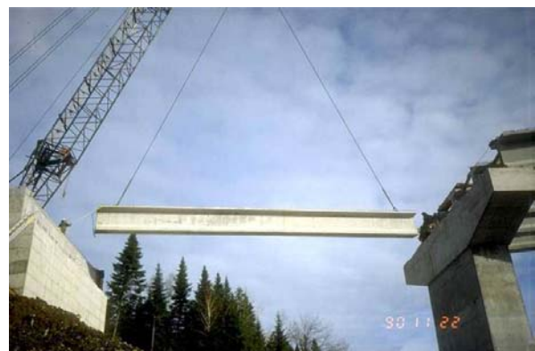
12. Mise en place d'une poutre préfabriquée
