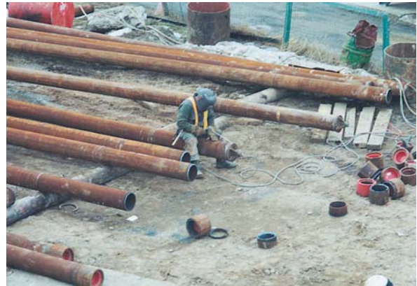
2. Pieux tubulaires en acier
