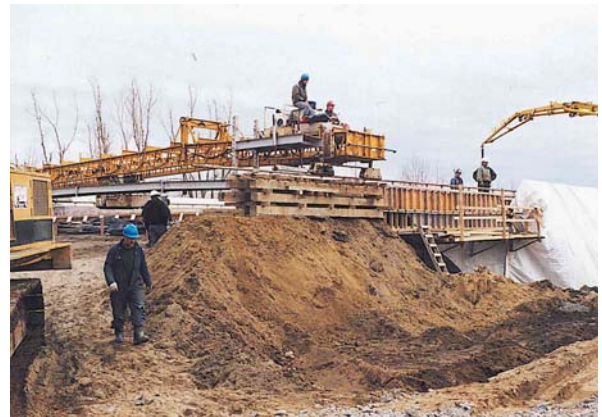
26. Remblai temporaire pour rail de roulement à l'approche d'un pont
