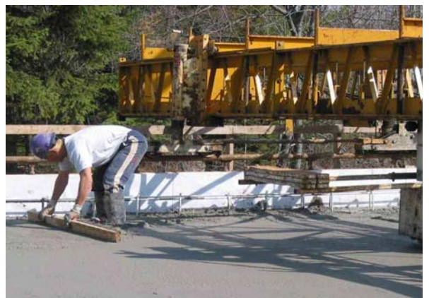
34. Finition manuelle des abords de dalle
