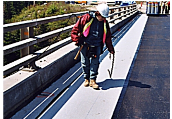
6. Vérification de l'adhérence de la membrane (chaîne)
