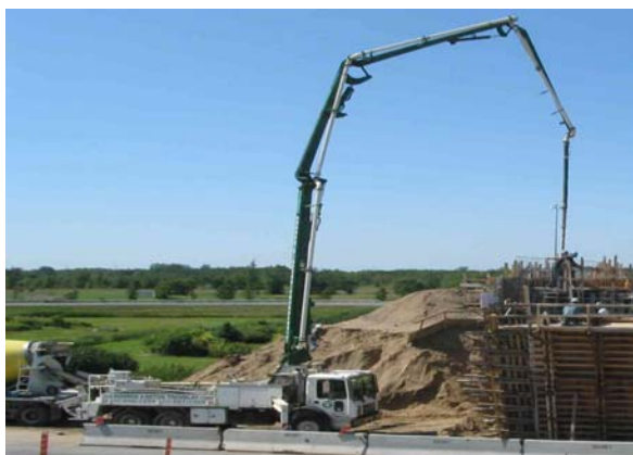
19. Pompe à béton
