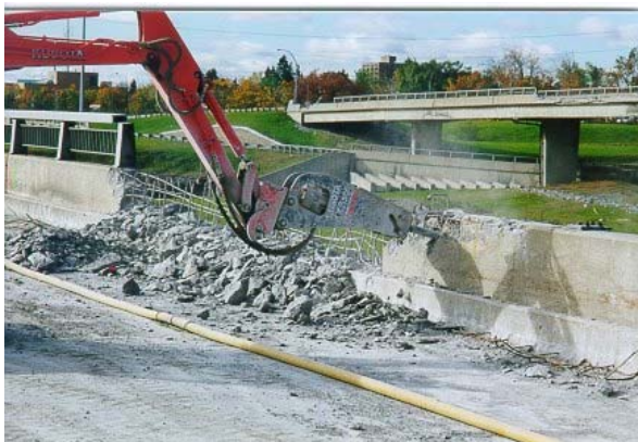
5. Démolition de glissière avec marteau hydraulique 350 J
