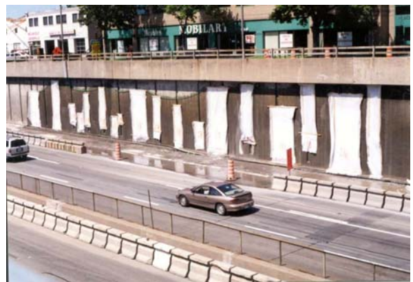
12. Cure humide du béton projeté
