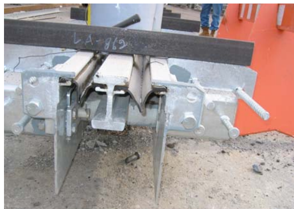
9. Joint de tablier à plus d'une garniture
