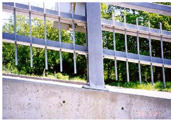
12. Dispositif de retenue avec poteaux posés selon la verticale (profil supérieur à 2 %)
