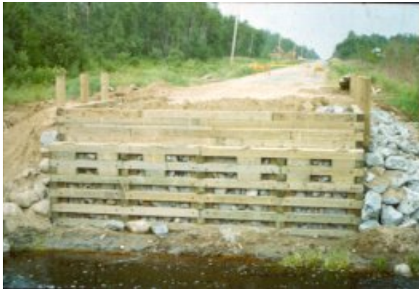
3. Culée de type caisson à claire-voie
