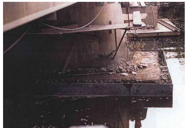
42. Coffrage métallique pour bétonnage sous l'eau
