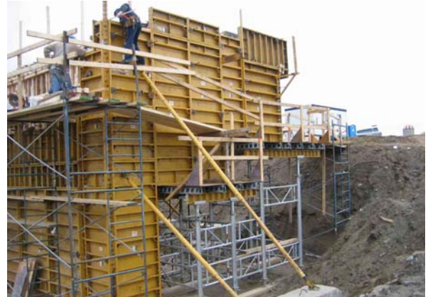
2. Coffrages verticaux préfabriqués
