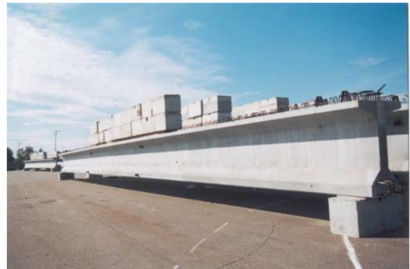
10. Chargement de poutres préfabriquées
