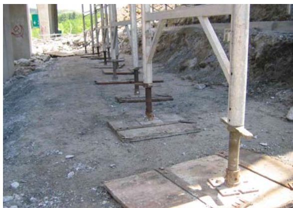
11. Détail de la base des étais (poteaux)
