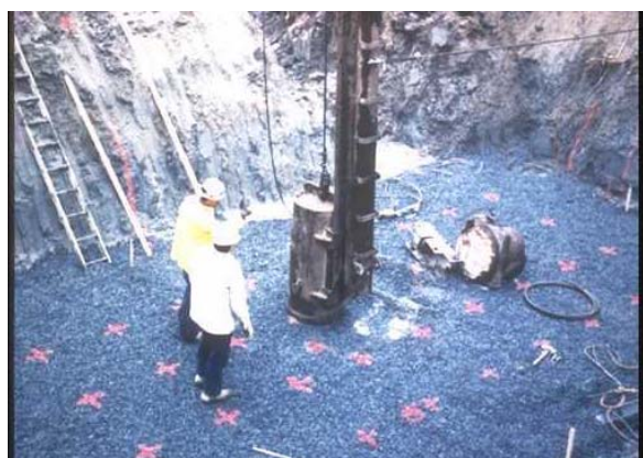
11. Repères pour localisation des pieux
