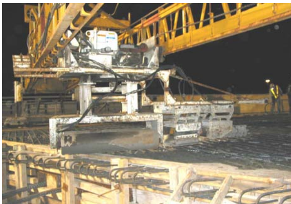
29. Détail du module mobile du finisseur automoteur
