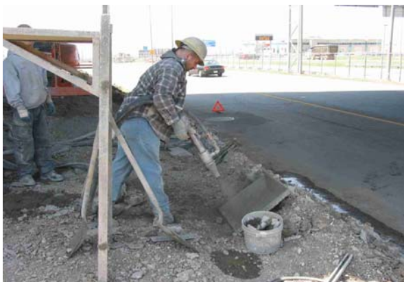
5. Projection d'un échantillon de béton
