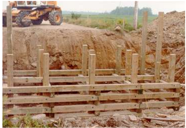
2. Début de construction d'un caisson à claire-voie
