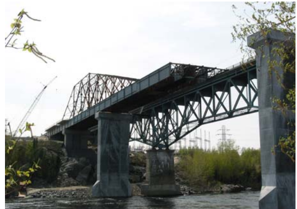
4. Ouvrage temporaire pour la mise en place des poutres par lancement
