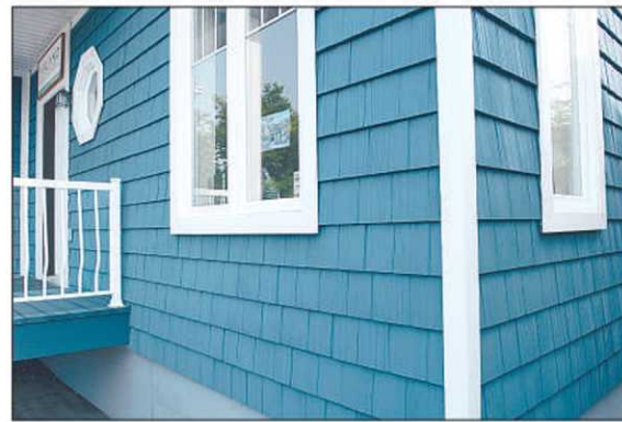
Maison en bardeaux de polymère Novik — PHOTO LE SOLEIL, STEVE DESCHÈNES
