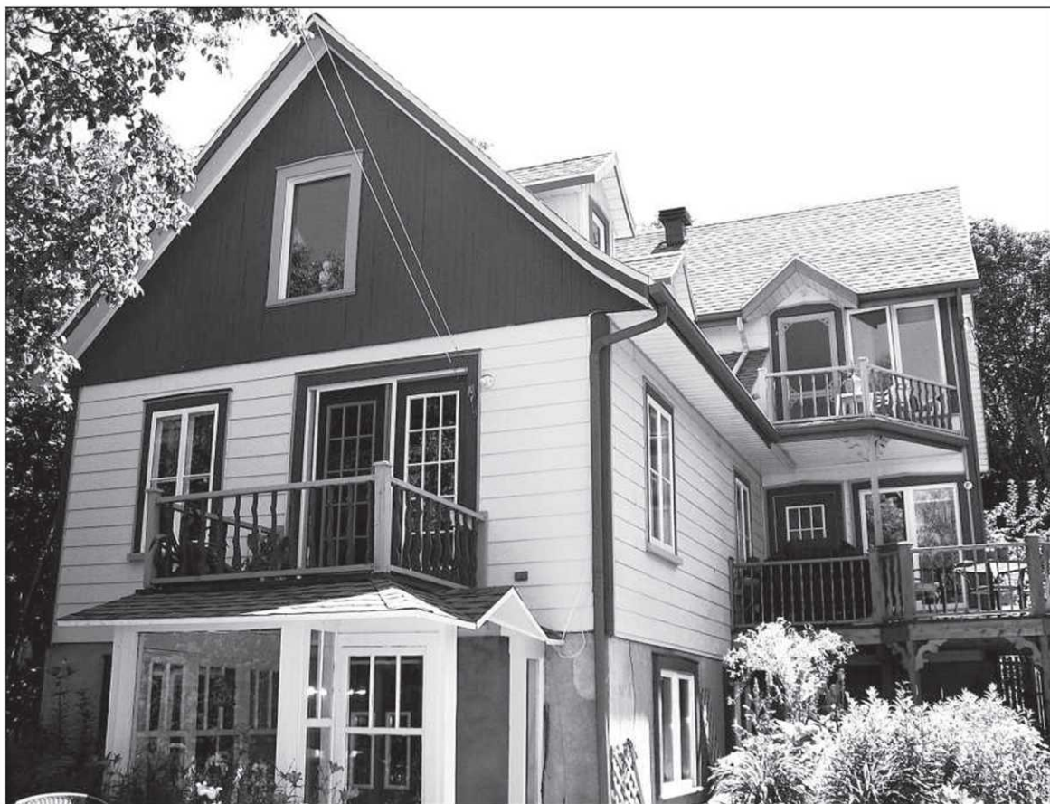
Depuis les travaux d'agrandissement, la « petite maison » originelle constitue l'arrière de la demeure (au premier plan sur la photo) : là où se trouvent la salle à manger et le salon au premier étage, la mezzanine et un bureau, au deuxième.
