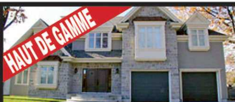
SILLERY, 1261, SUZOR-COTÉ , luxueux et raffiné 4 cc, 1 bur., 2 sb, 1 se, 2 foyers au gaz, lattes/céram., thermopompe et garage double.
