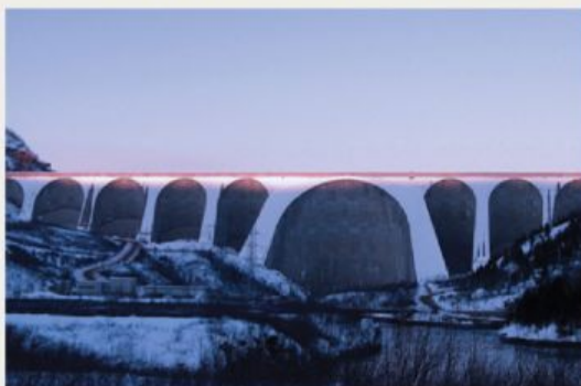
Barrage de Manic V
