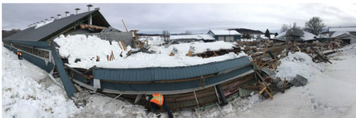
Effondrement d'un bâtiment agricole
