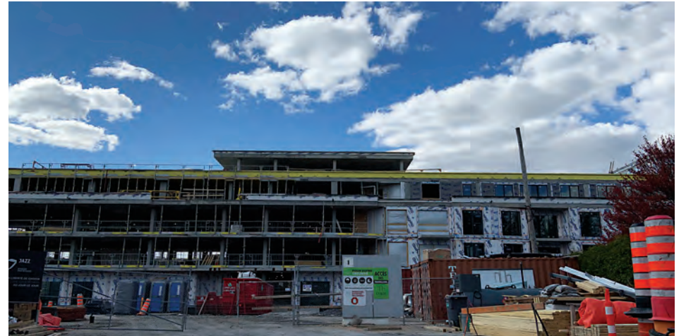
La grue qui trônait au-dessus de l'immeuble en construction ne surplombe plus le chantier. (Photo : Frank Jr Rodi)
