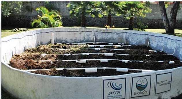
Unité de biofiltration BIOTROP MD installée au Mexique
