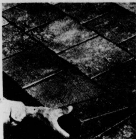
FIGURE 1: Ici, on utilise des blocs de 8 pouces carrés avec quelques briques. Après avoir étendu le sable à l'aide d'un râteau, on pose chacun des blocs en le nivelant individuellement. Si le bloc est trop élevé ou trop bas, on enlève ou on remet un peu de sable, selon le cas.
