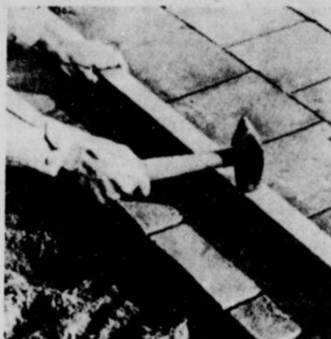
FIGURE 2: Après avoir posé une rangée complète de blocs, on les entasse plus fermement en utilisant un morceau de bois (2 x 2) et un maillet. Si l'un des blocs se déplace, on le soulève pour ajouter ou enlever le sable requis ou en trop.
